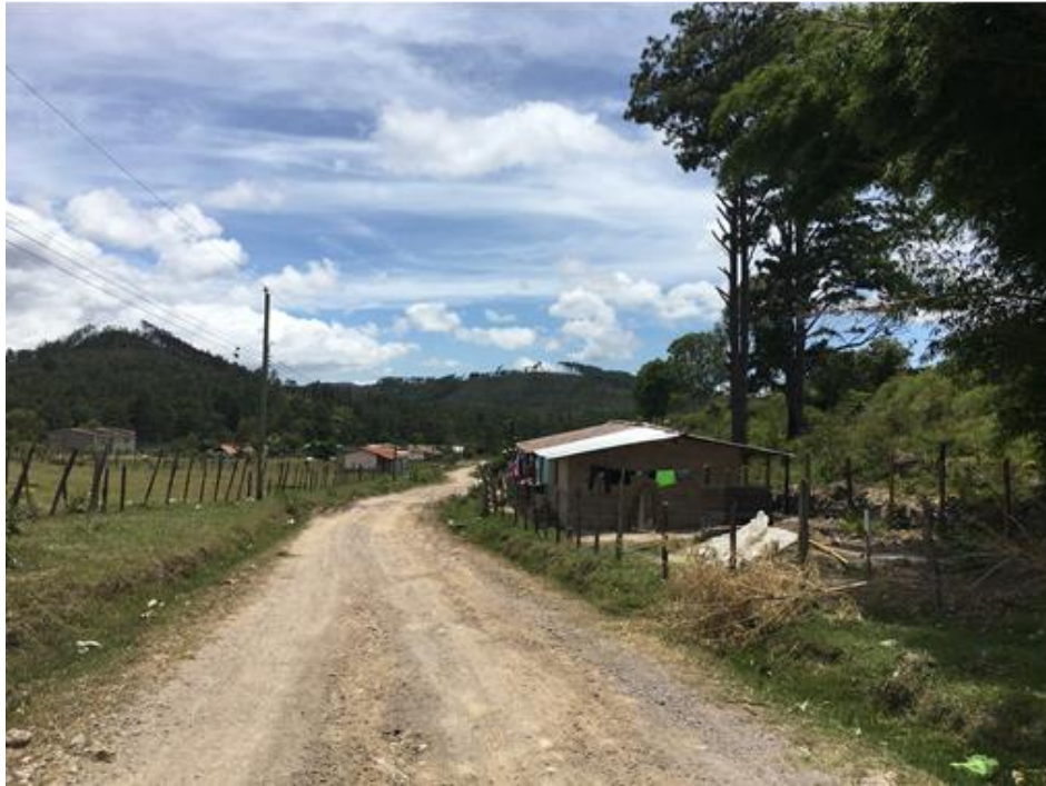
Inicio del tramo en el que se hará el balastado
