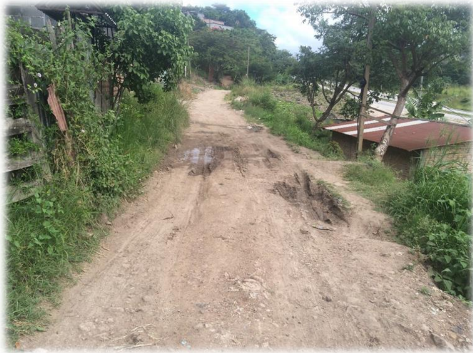
Vista de calle donde se construirán las huellas
