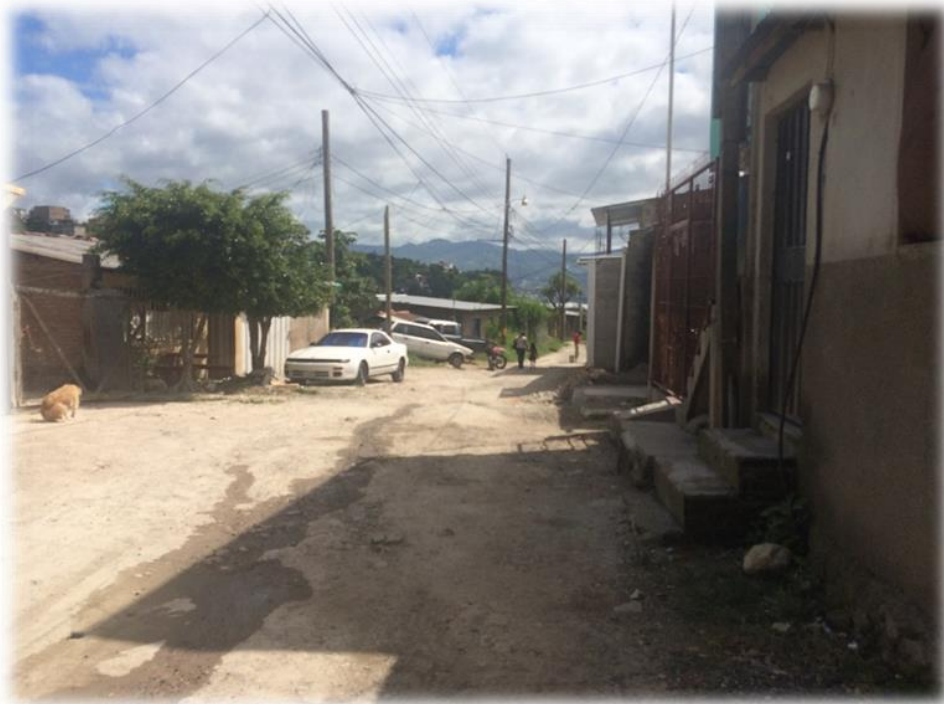
Inicio de pavimentación con concreto hidráulico
