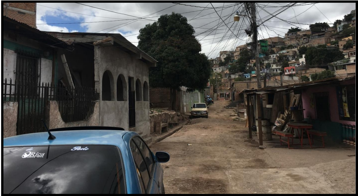
VISTA DEL INICIO DEL TRAMO A PAVIMENTAR
