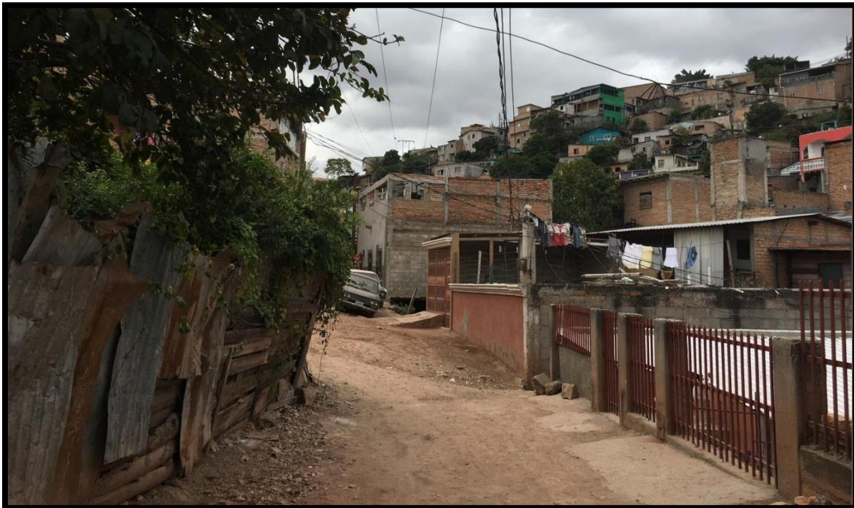
PANORAMA DE LA CALLE A PAVIMENTAR
