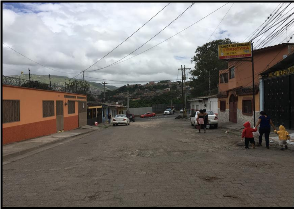
Inicio de calle a pavimentar con concreto hidráulico
