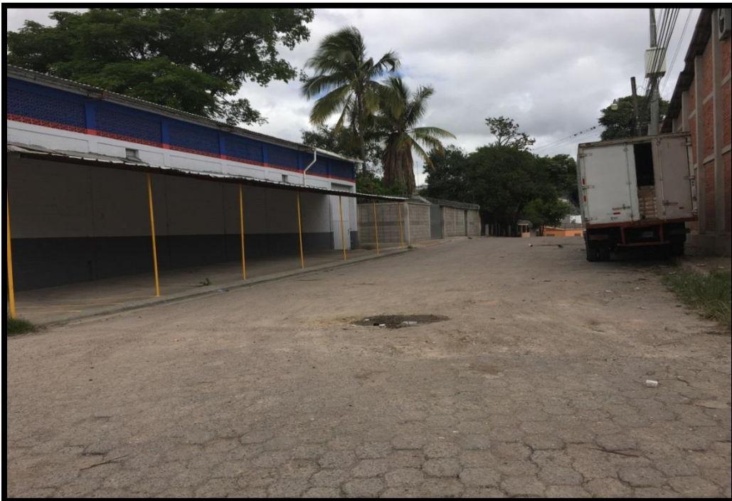
Panorama de la calle donde se desmontara el adoquin existente
