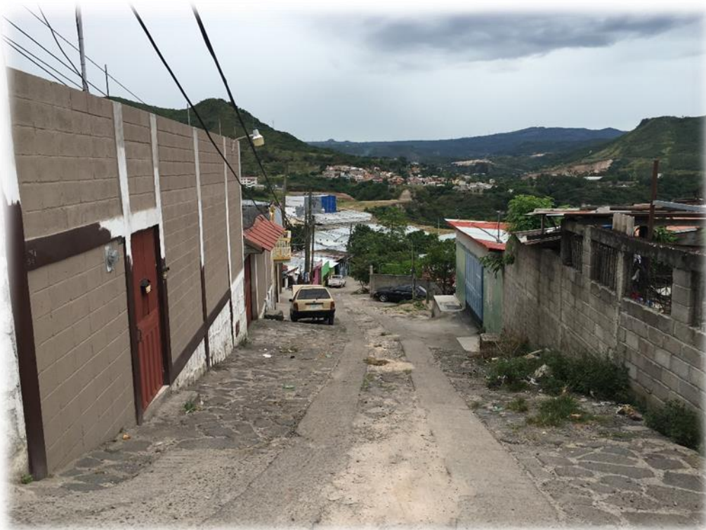
VISTA DE CALLE EXISTENTE A DEMOLER
