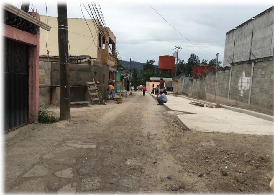
FINAL DE PAVIMENTO CON CONCRETO HIDRÁULICO
