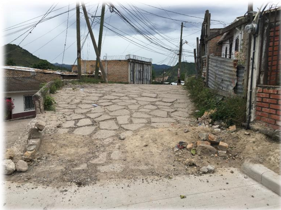
INICIO DE PAVIMENTACIÓN CON CONCRETO HIDRÁULICO.
