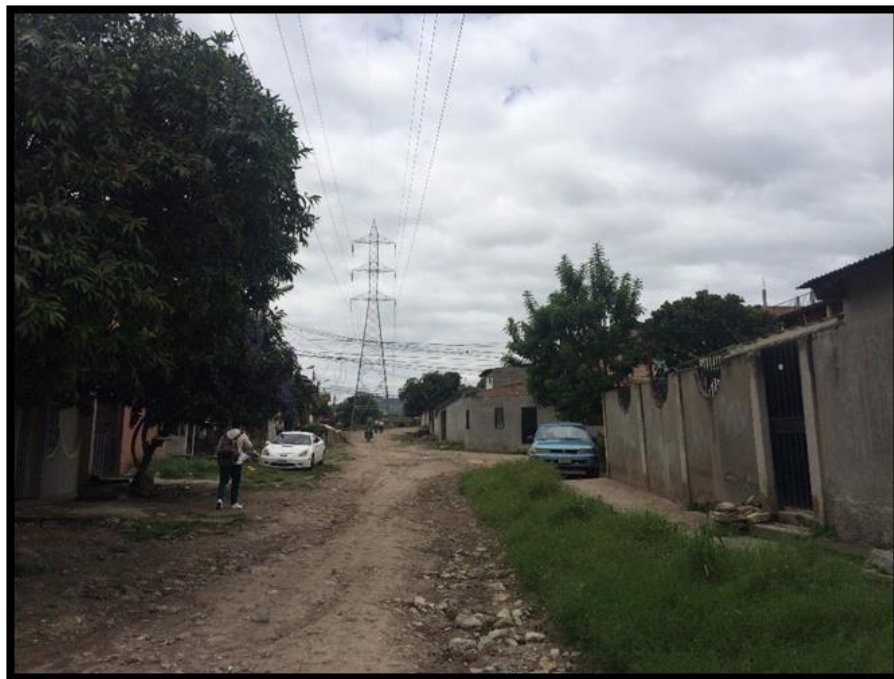
Panoramica del tramo a pavimentar
