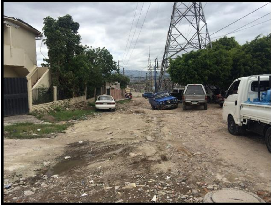
Panoramica del tramo a pavimentar
