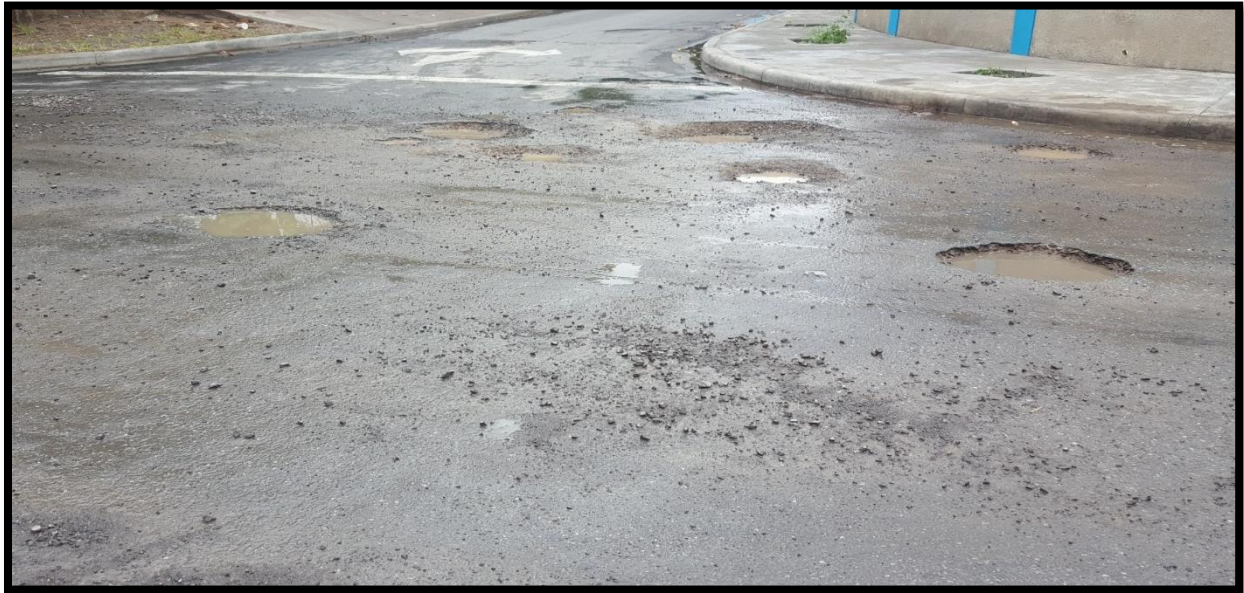
VISTA DEL INICIO DE LA REPARACIÓN
