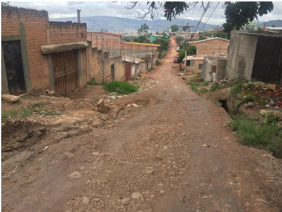
Vista estado actual de calle a pavimentar
