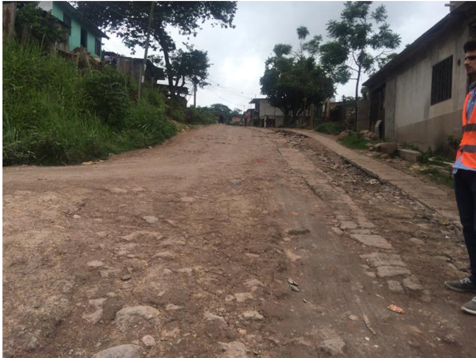
Vista panorámica de calle a pavimentar y elementos a demoler
