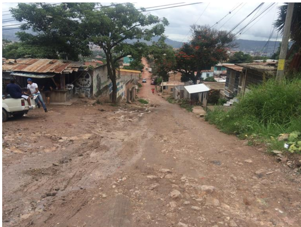
Vista panorámica de calle a pavimentar y construcción cuneta
