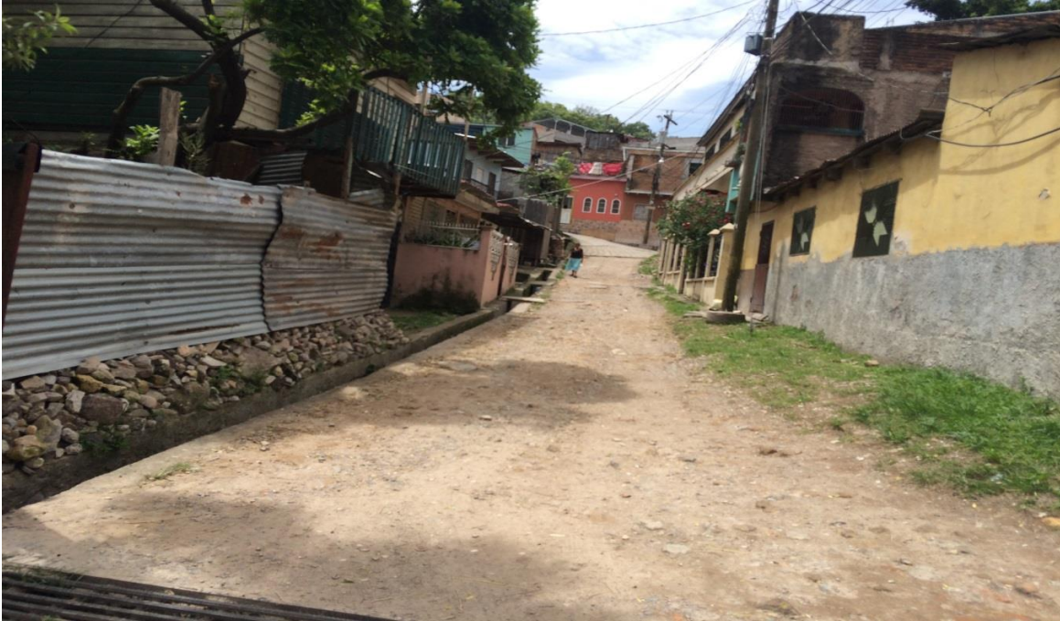
Calle a pavimentar
