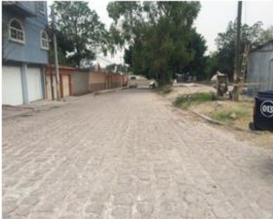
Calle a pavimentar con white topping
