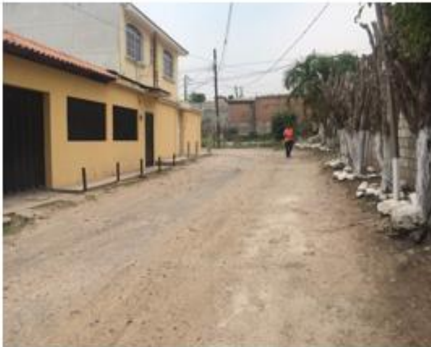
Vista de calle a pavimentar
