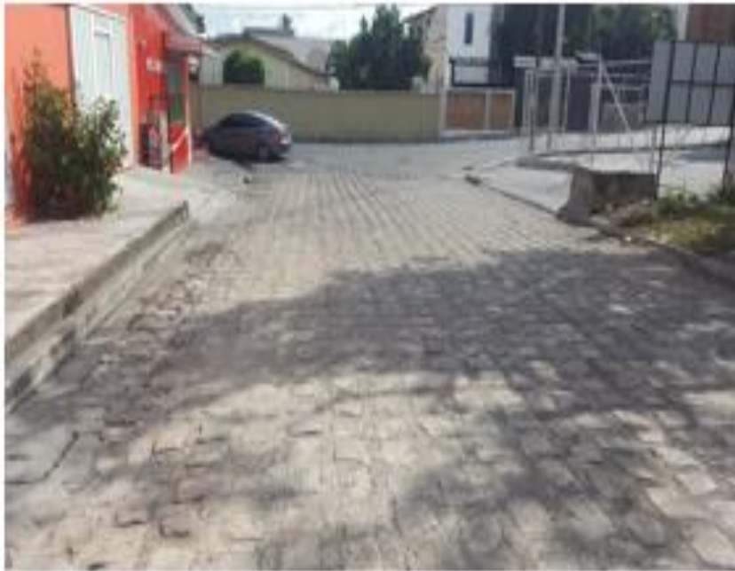
Inicio del primer tramo a Pavimentar
