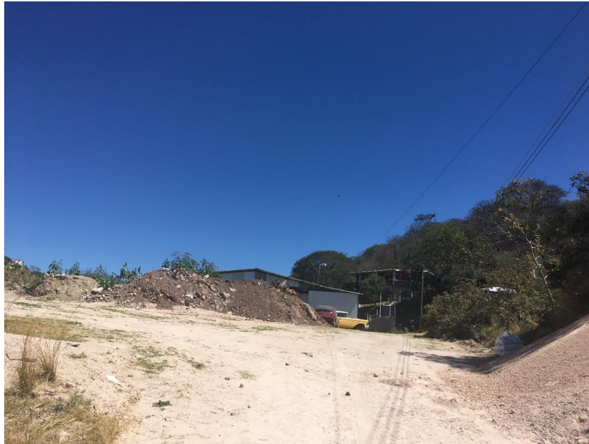
Foto No. 3: Vista de calle a pavimentar
