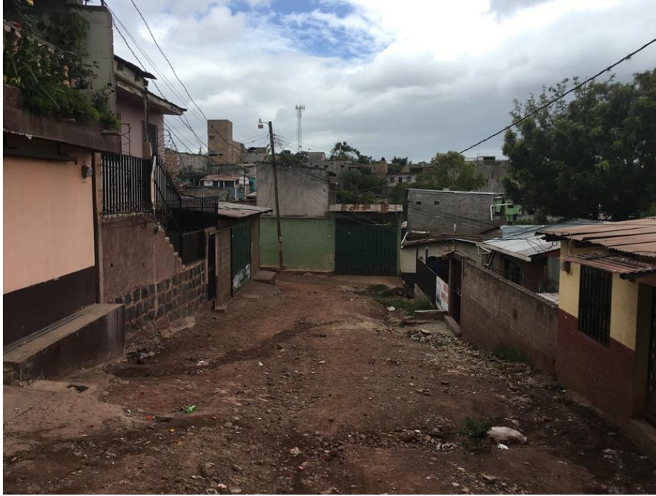
VISTA PANORAMICA DE LA CALLE A PAVIMENTAR
