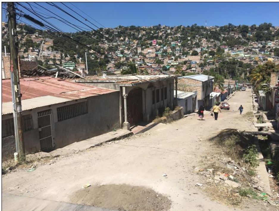
INICIO DE TRAMO A PAVIMENTAR CON CONCRETO HIDRÁULICO
