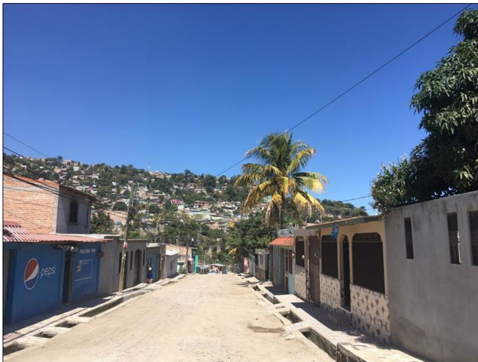
VISTA PANORAMICA DE CALLE A PAVIMENTAR CON CONCRETO HIDRAULICO
