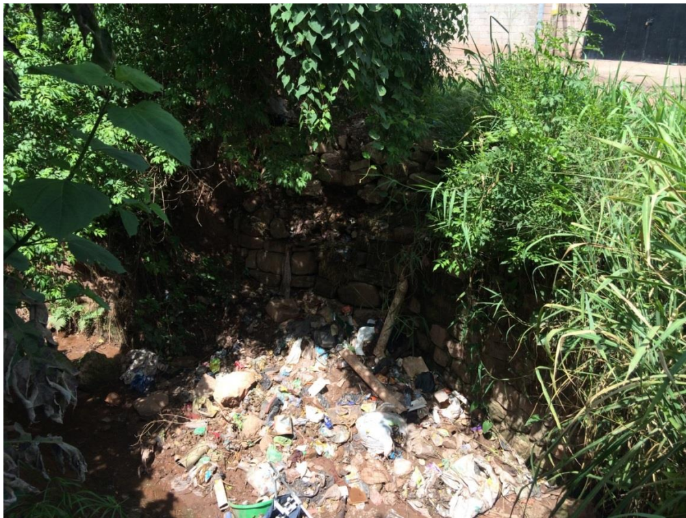
VISTA DE LA CONSTRUCCION DEL MURO
