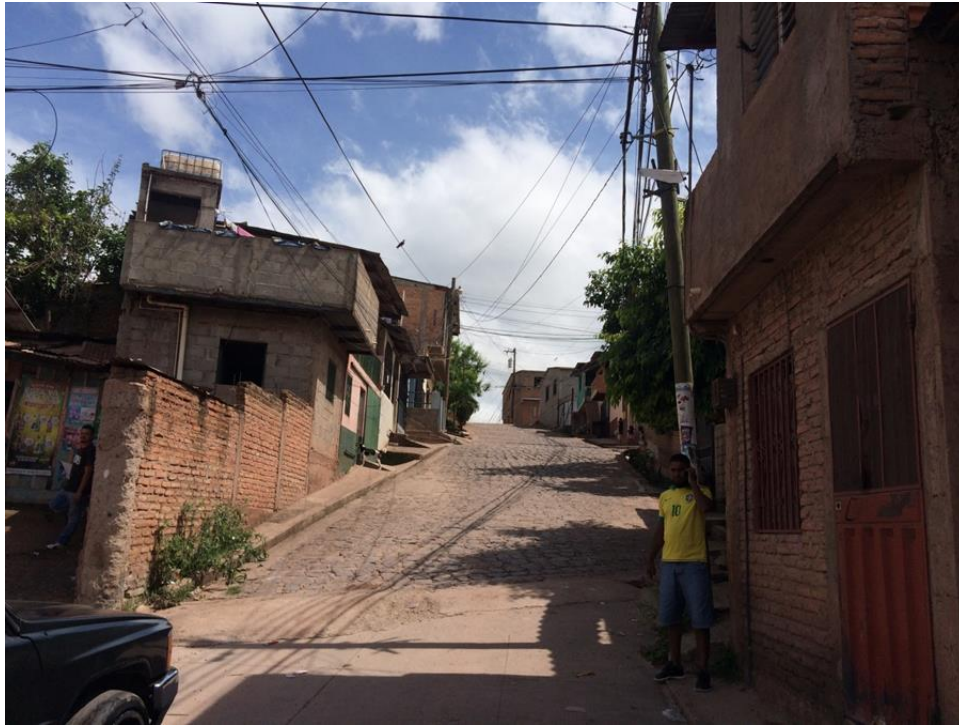
INICIO DE WHITE TOPPING
