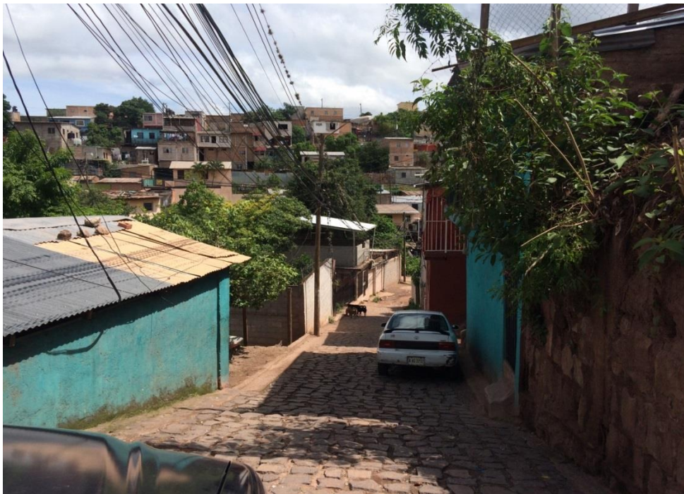
VISTA DE LA REPARACION DEL EMPEDRADO Y WHITE TOPPING
