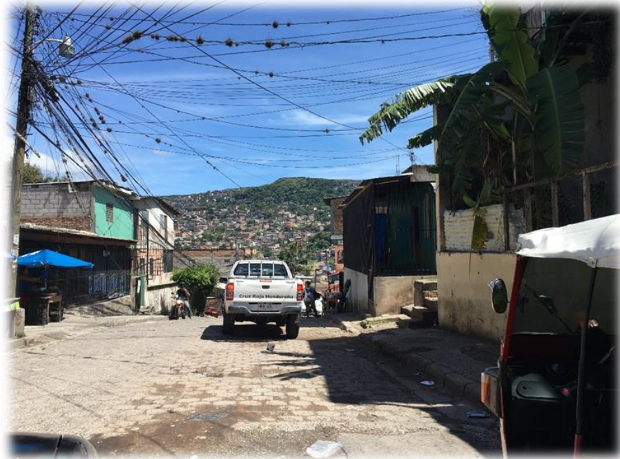
Inicio de pavimentación con concreto hidráulico
