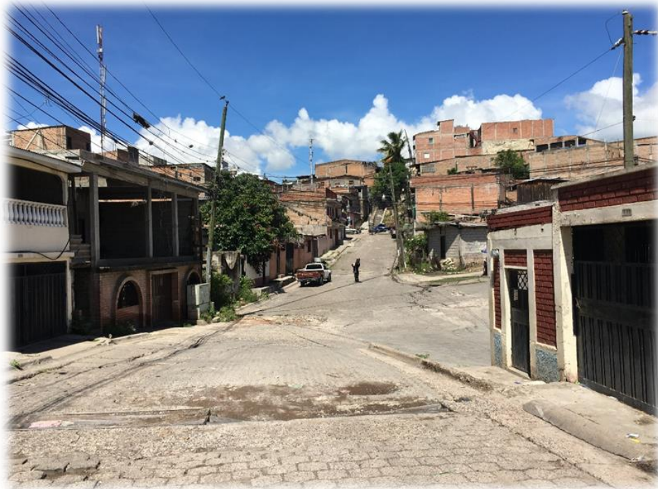
Vista final de calle a pavimentar
