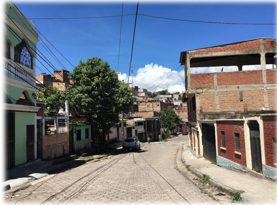
Vista de calle donde se desmontara el adoquín
