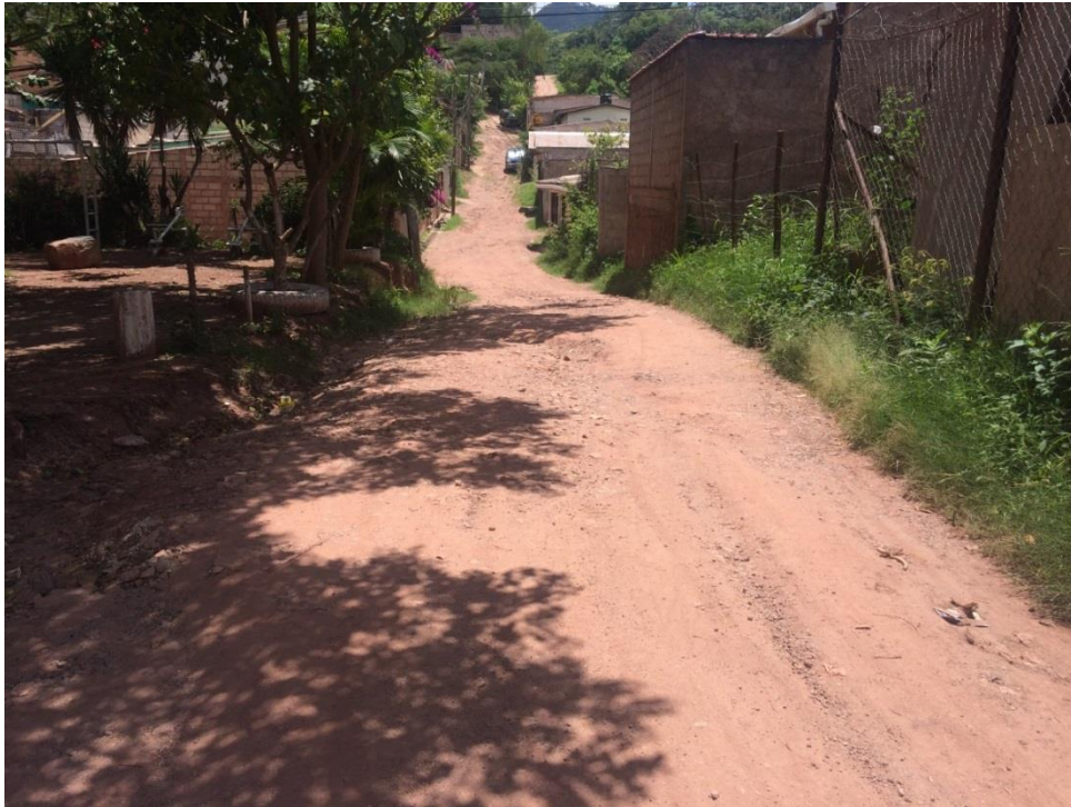
Inicio de calle a pavimentar
