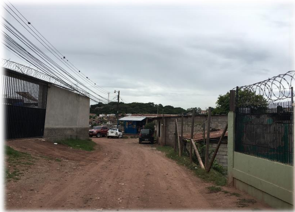
INICIO DE CONSTRUCCIÓN DE HUELLAS VEHICULARES
