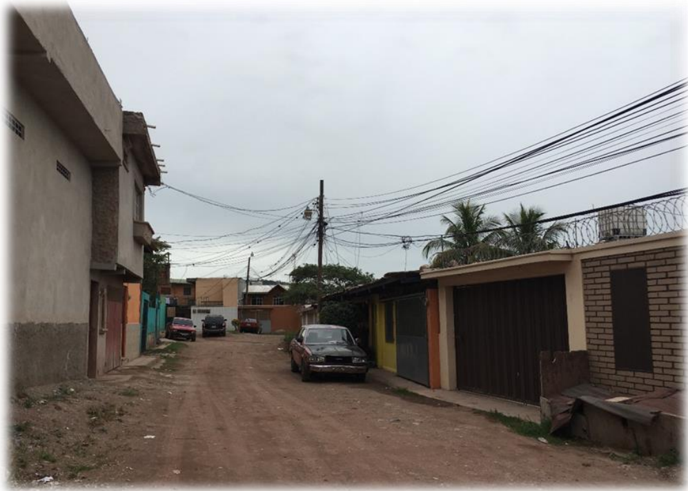
VISTA DE CALLE DONDE SE CONSTRUIRA LAS HUELLAS VEHICULARES
