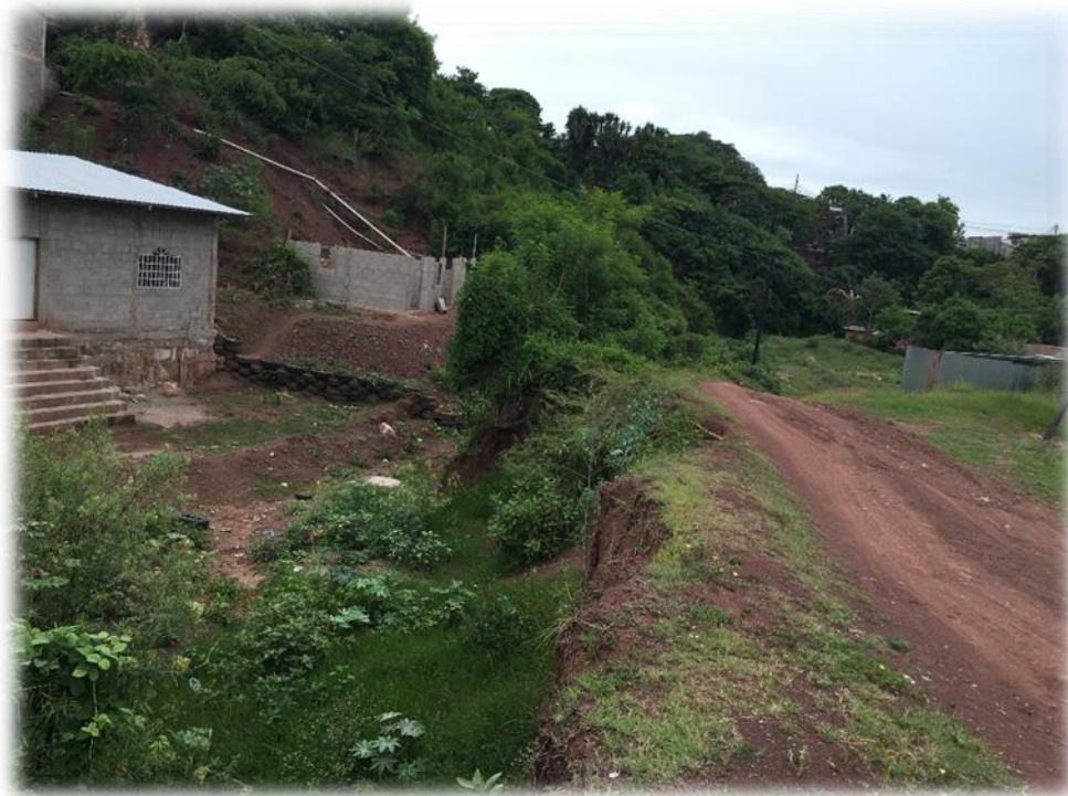
VISTA DE DONDE SE CONSTRUIRA EL MURO DE CONTENCIÓN
