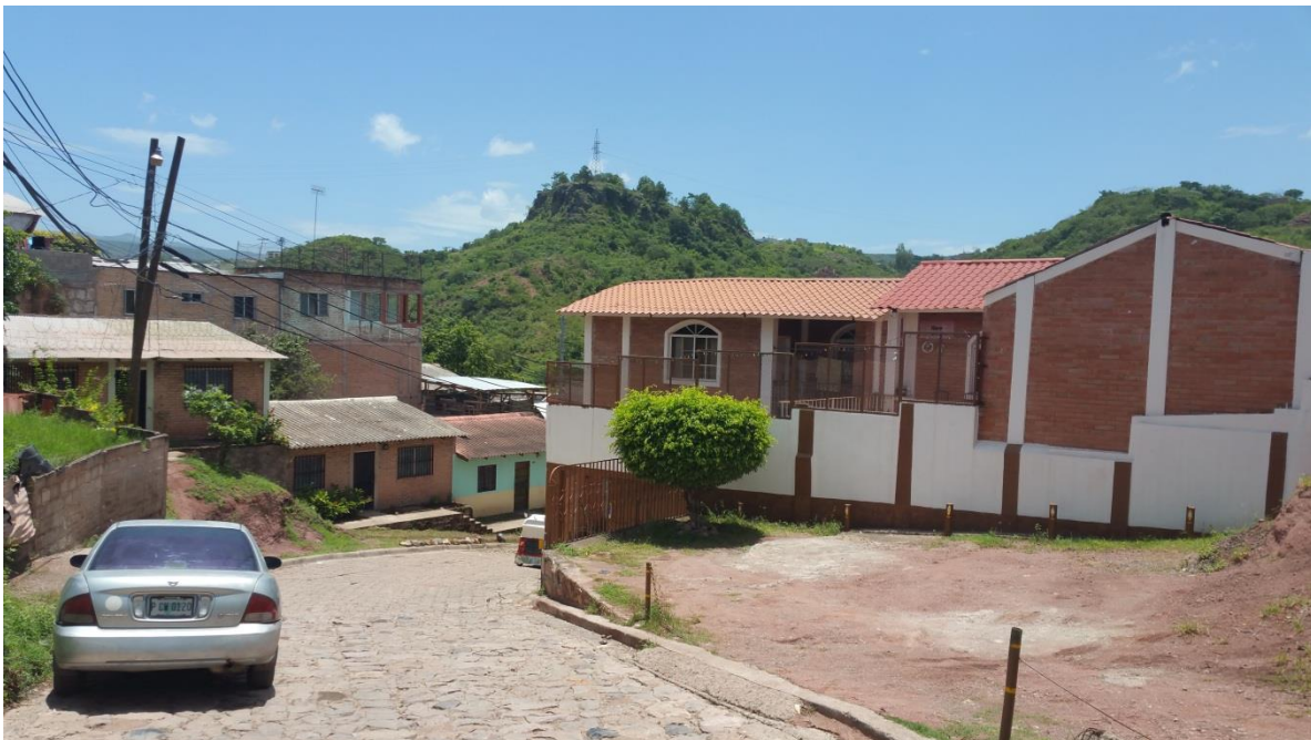
Vista de calle a reparar empedrado y pavimentar con white topping
