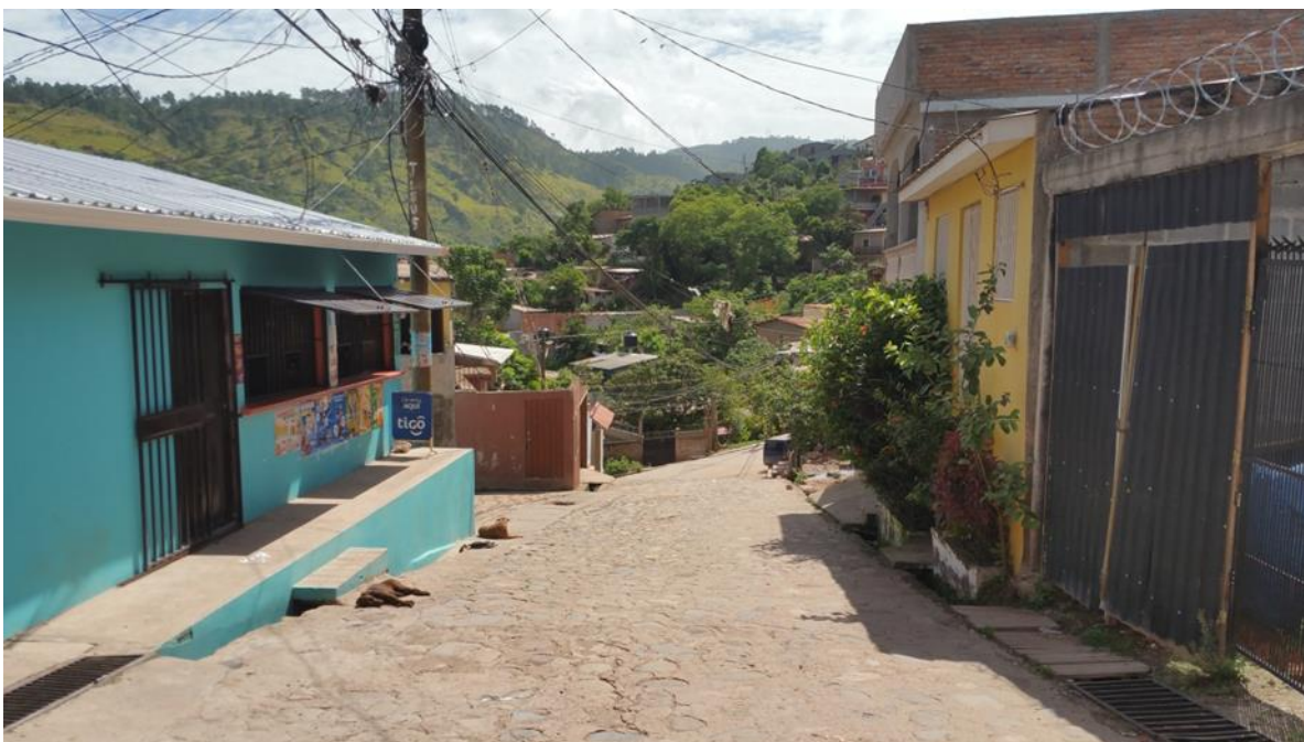
Panorama de calle a pavimentar con white topping
