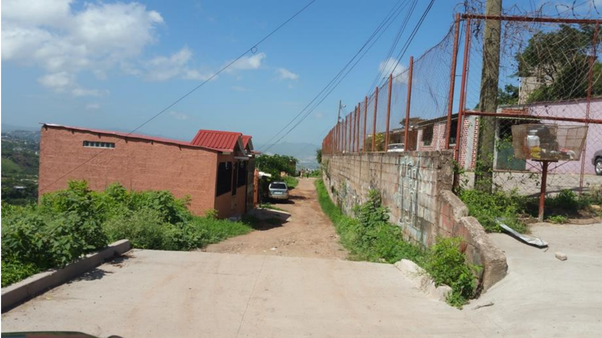
Inicio de calle a pavimentar con concreto hidráulico
