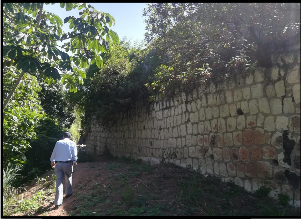
No.3 Vista frontal del muro existente
