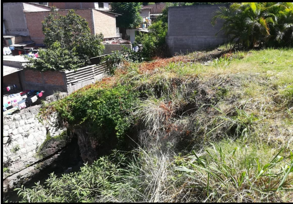
No.4 Vista del terreno que se ha perdido y que se deberá rellenar
