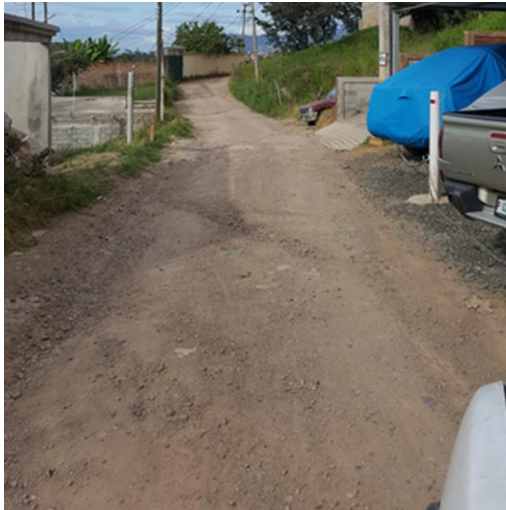
PANORAMA DE CALLE A PAVIMENTAR CON CONCRETO HIDRÁULICO
