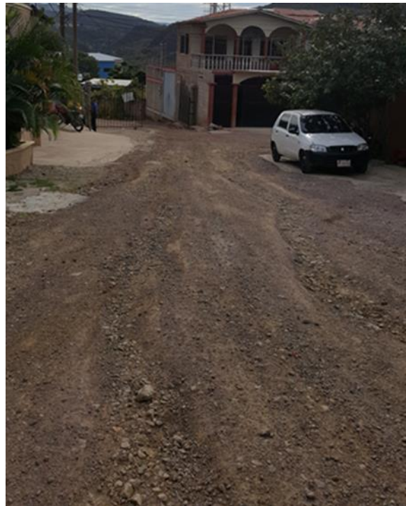
VISTA PANORÁMICA DE CALLE A PAVIMENTAR CON CONCRETO HIDRÁULICO
