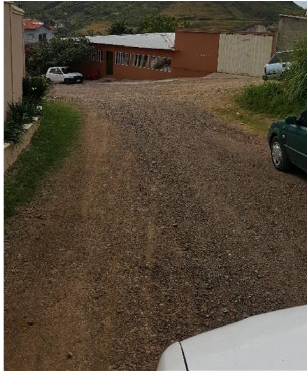
VISTA DE CALLE A PAVIMENTAR CON CONCRETO HIDRÁULICO
