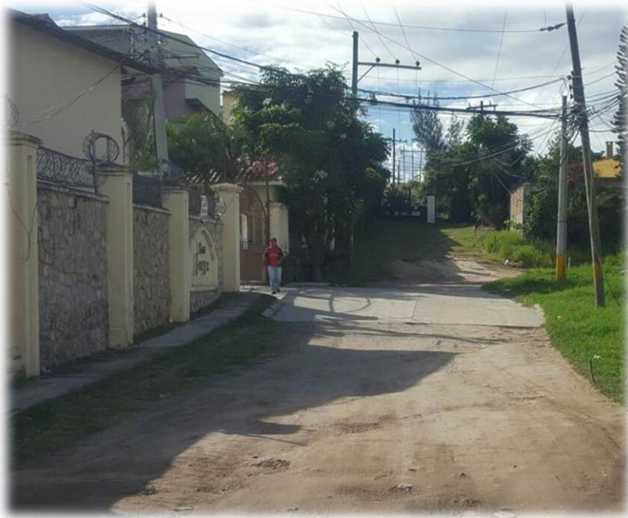
PANORAMA DE CALLE A PAVIMENTAR CON CONCRETO HIDRÁULICO
