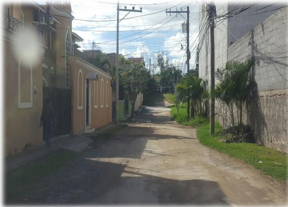
FINAL DE CALLE A PAVIMENTAR CON CONCRETO HIDRÁULICO
