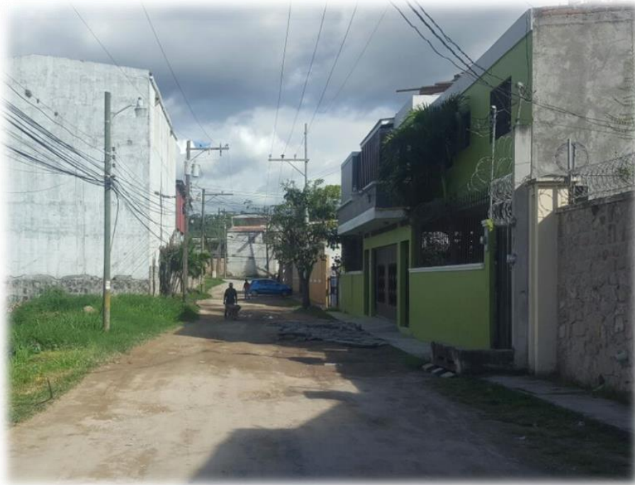
INICIO DE CALLE A PAVIMENTAR CON CONCRETO HIDRÁULICO
