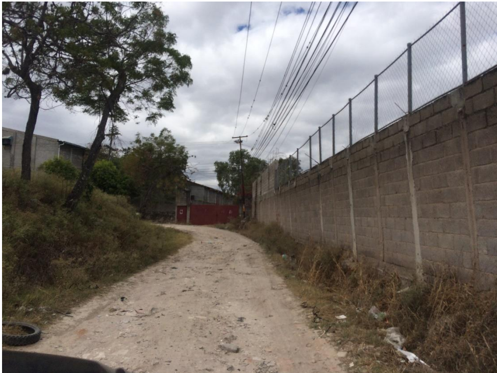
VISTA DE LA CALLE A PAVIMENTAR CON CONCRETO HIDRÁULICO Y CONSTRUCCION DE CUNETETA
