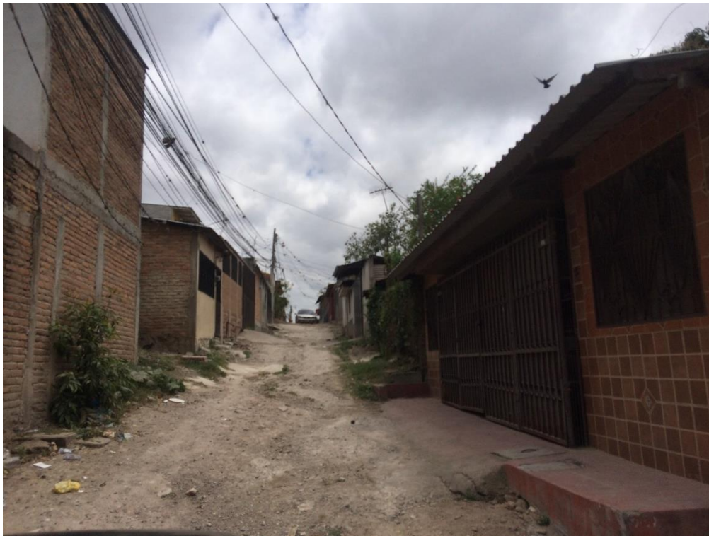
SE OBSERVA EL MAL ESTADO DE LA CALLE
