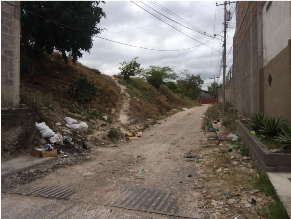
INICIO DE CALLE A PAVIMENTAR
