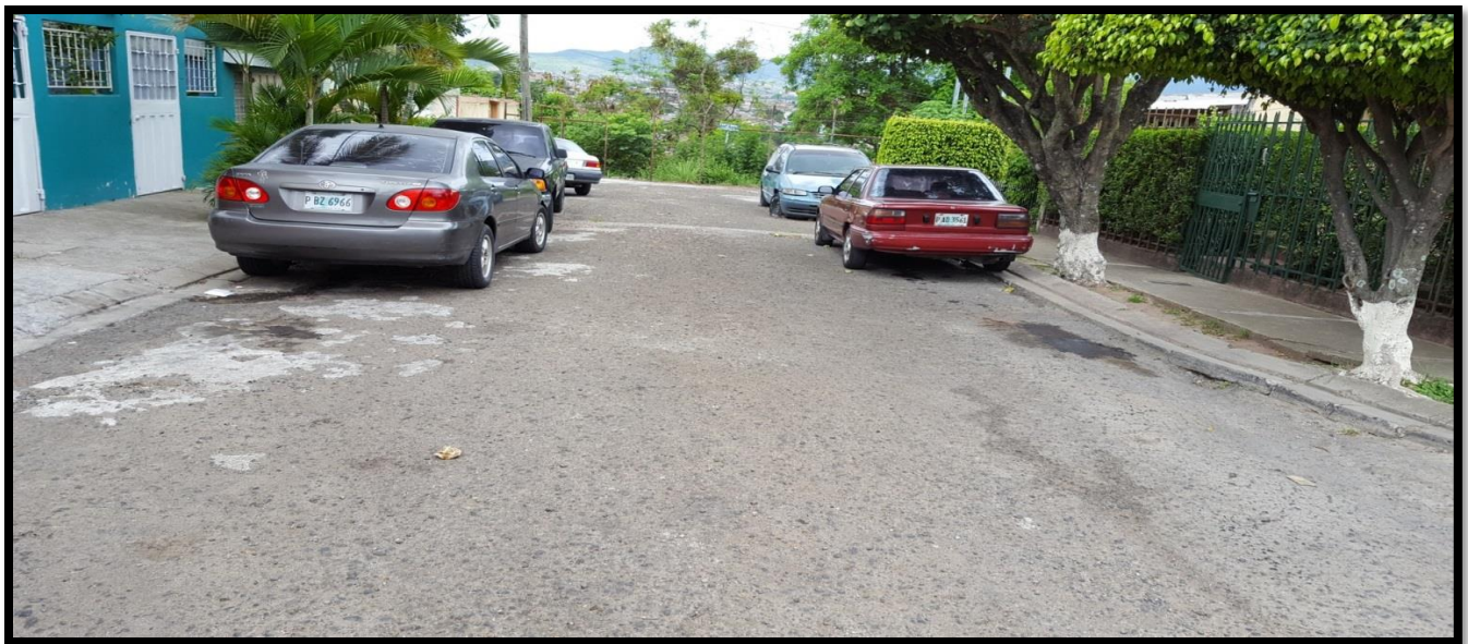
Vista del tramo a trabajar con mezcla Asfáltica
