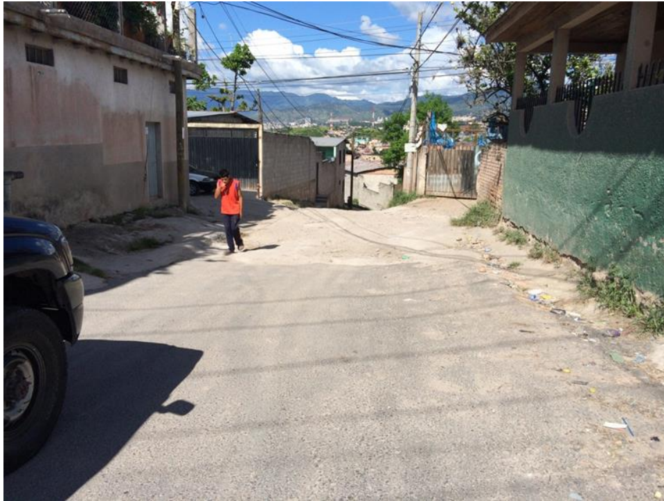
INICIO DE PAVIMENTACIÓN CON CONCRETO HIDRÁULICO
