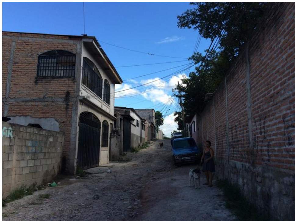
PANORAMICA A PAVIMENTAR CON CONCRETO HIDRÁULICO
