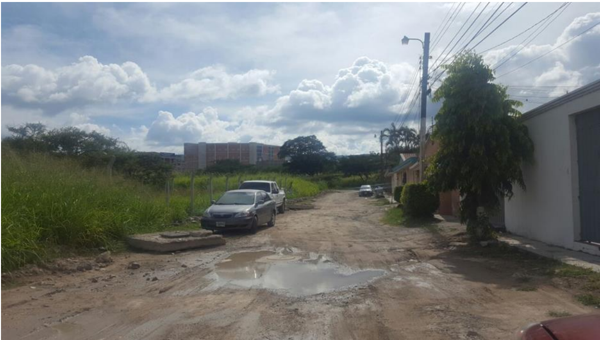
PANORAMA DE CALLE A PAVIMENTAR CON CONCRETO HIDRÁULICO
