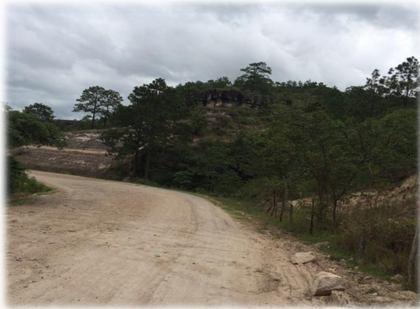
INICIO DE PAVIMENTACIÓN CON CONCRETO HIDRÁULICO
