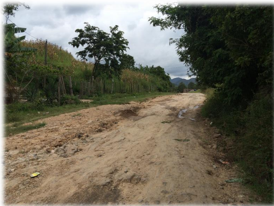
ESTADO DE CALLE A PAVIMENTAR
