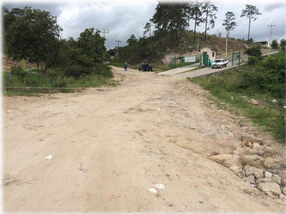
FINAL DE LA CALLE A PAVIMENTAR
