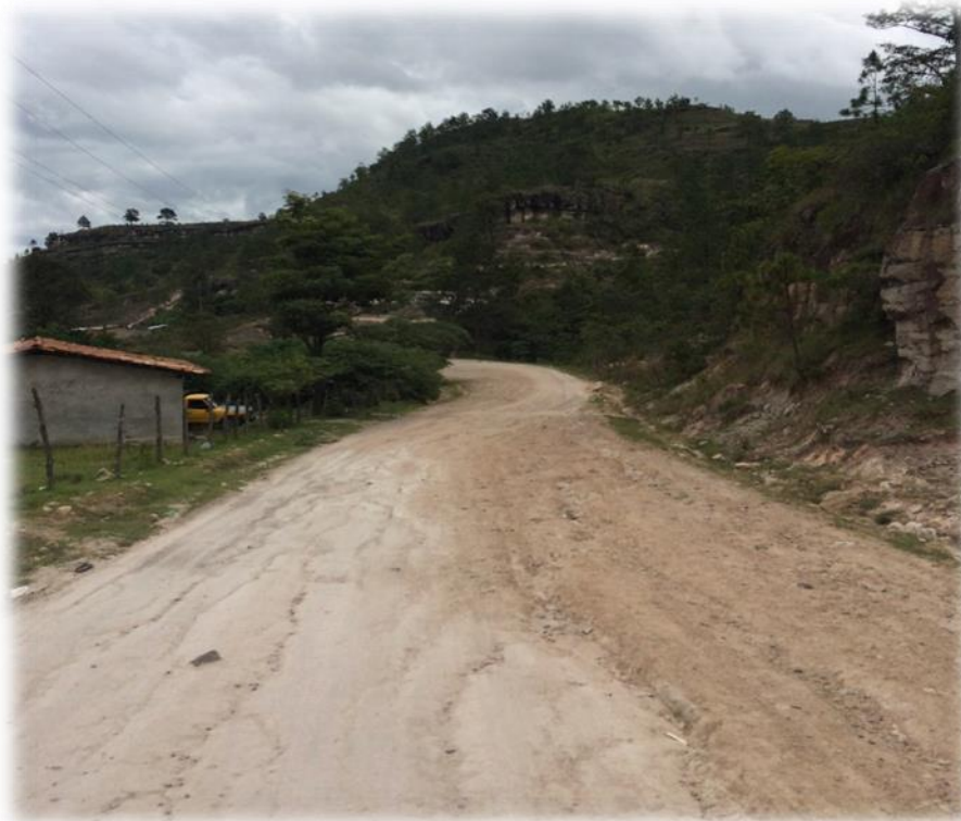
VISTA DEL ESTADO DE LA CALLE A PAVIMENTAR
