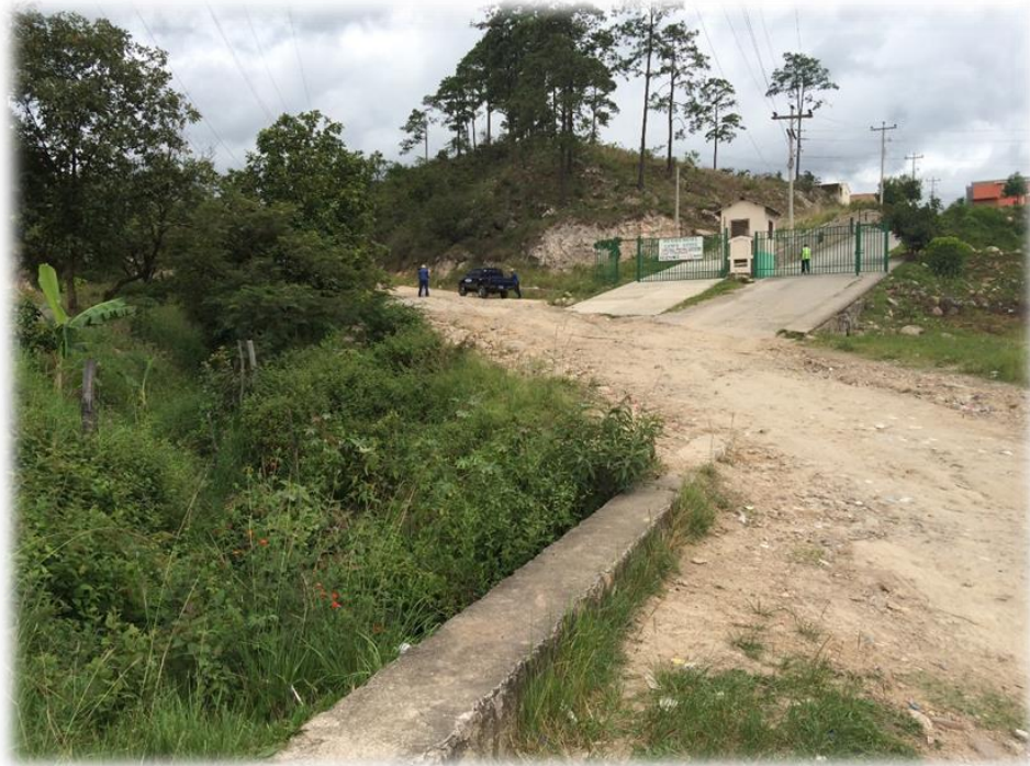
VISTA DE DONDE SE CONTRUIRA EL TRAMO DE CUNETA
