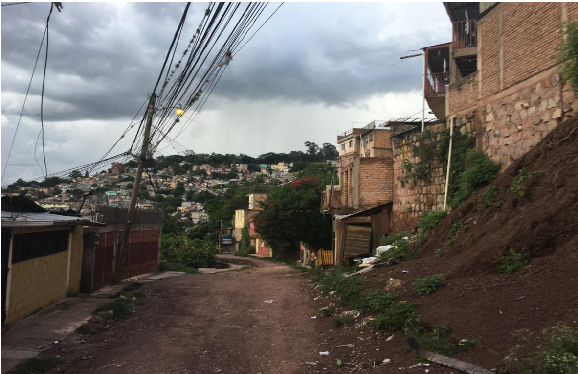
Calle donde se hará el muro de contención y la pavimentación con concreto hidráulico
