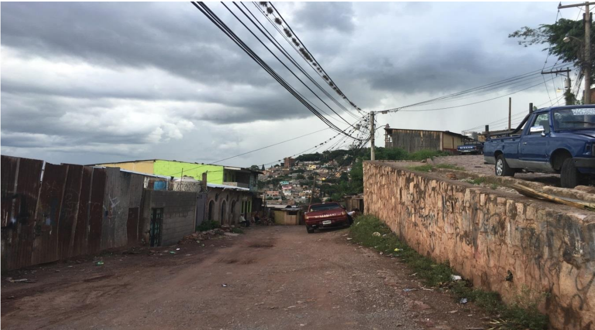
Estado de calle a pavimentar con concreto hidráulico
