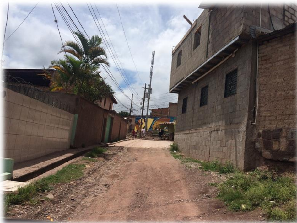
FINAL DE PAVIMENTO CON CONCRETO HIDRÁULICO
