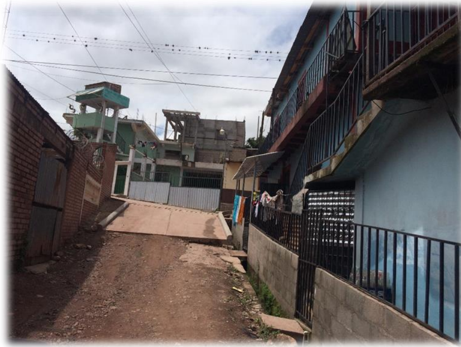
INICIO DE PAVIMENTACIÓN CON CONCRETO HIDRÁULICO
