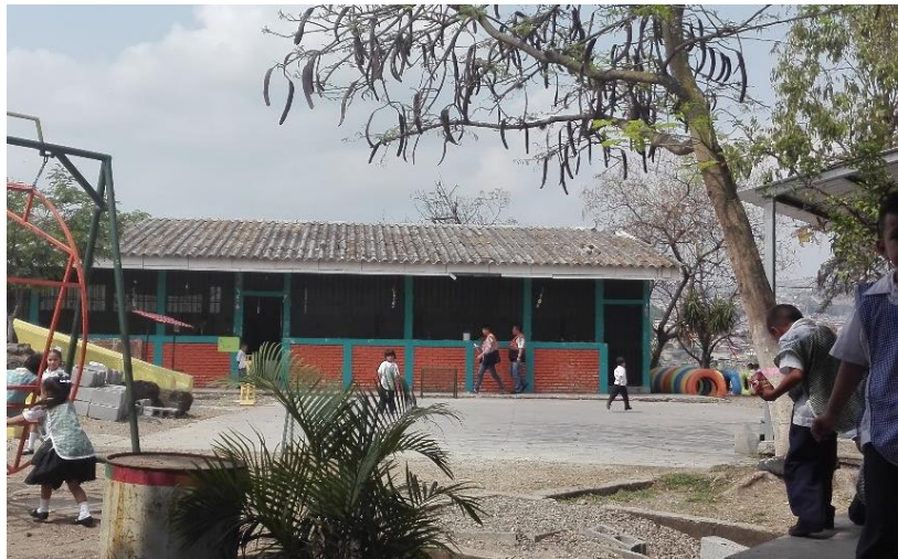
No. 2 VISTA DE MODULO DE AULA I, DONDE SE REALIZARA CAMBIO DE CUBIERTA, SE DEMONTARA TECHO DE ESCENARIO Y SE TECHARA LA CANCHA.
