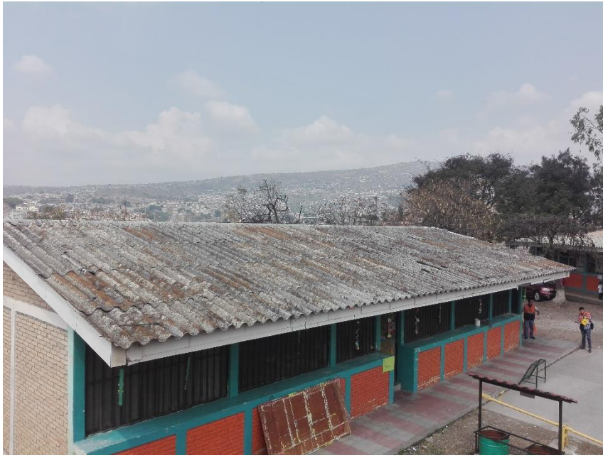
No. 1 VISTA DE AULAS DONDE SE REALIZARÁ CAMBIO DE CUBIERTA.
