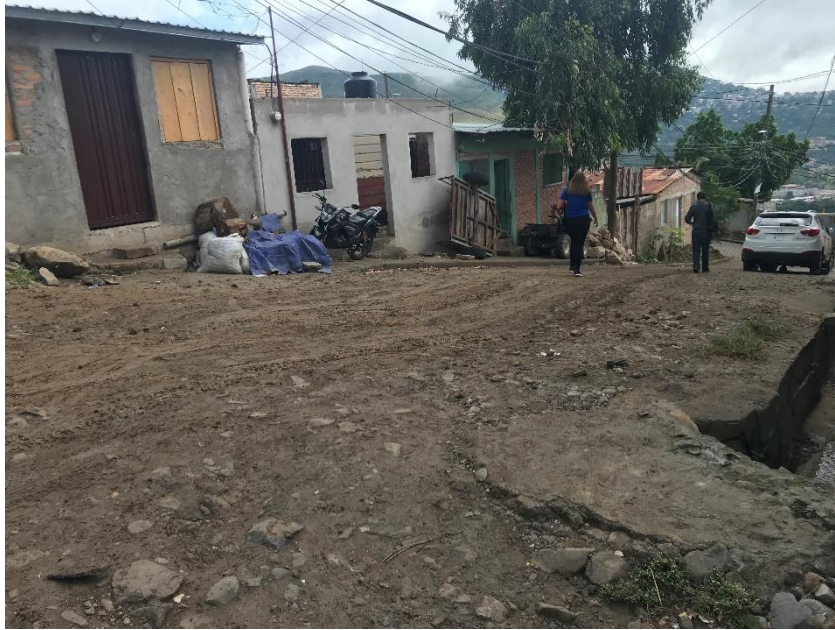
No.1 SE PUEDE APRECIAR EL INICIO DE LA CALLE A PAVIMENTAR
