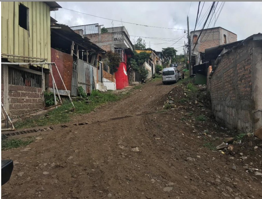
No.2 SE PUEDE OBSERVAR EL ESTADO DE LA CALLE Y LA NECESIDAD DE PAVIMENTAR
