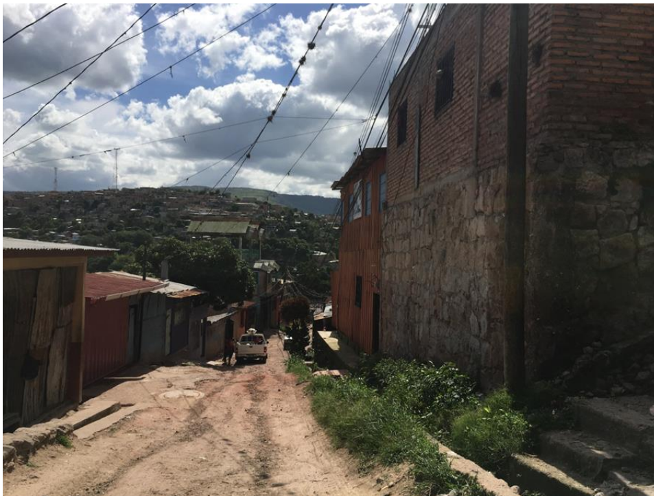
VISTA DE LA CALLE EN MAL ESTADO
