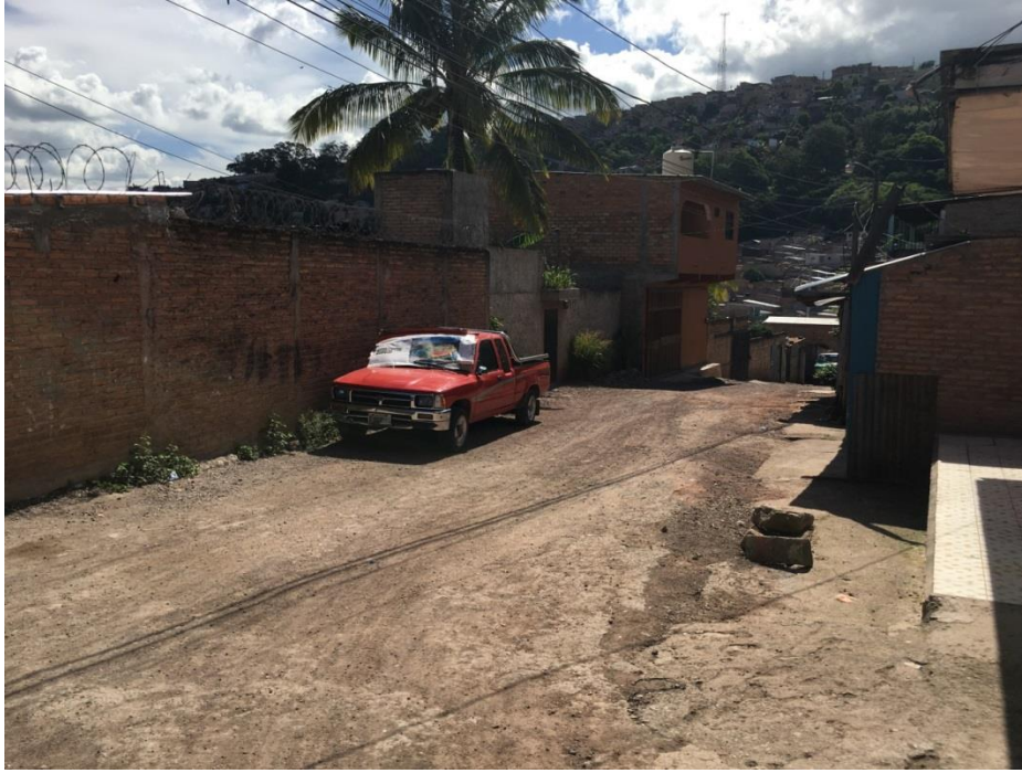
VISTA PANORAMICA DE LA CALLE A PAVIMENTAR
