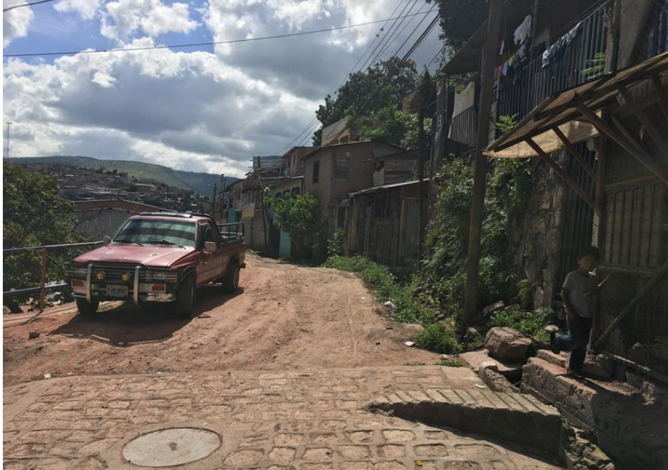
INICIO DE LA CALLE A PAVIMENTAR
