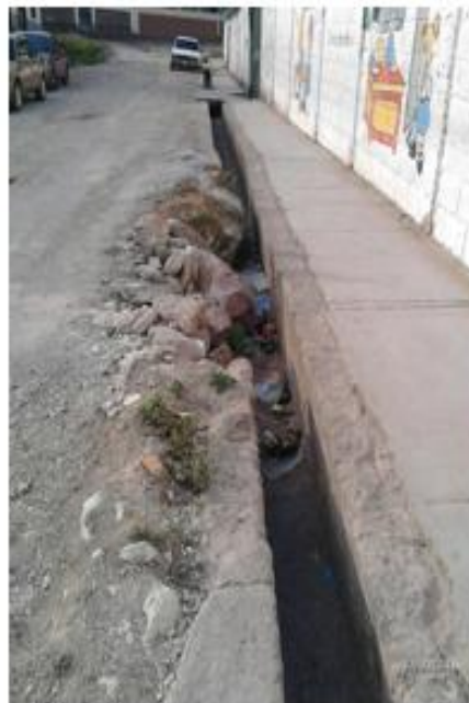
2. VISTA DE ESTADO ACTUAL DE CALLE A PAVIMENTAR
