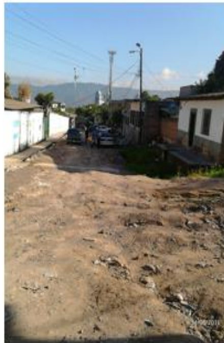
4. VISTA DE ESTADO ACTUAL DE LA CALLE A PAVIMENTAR
