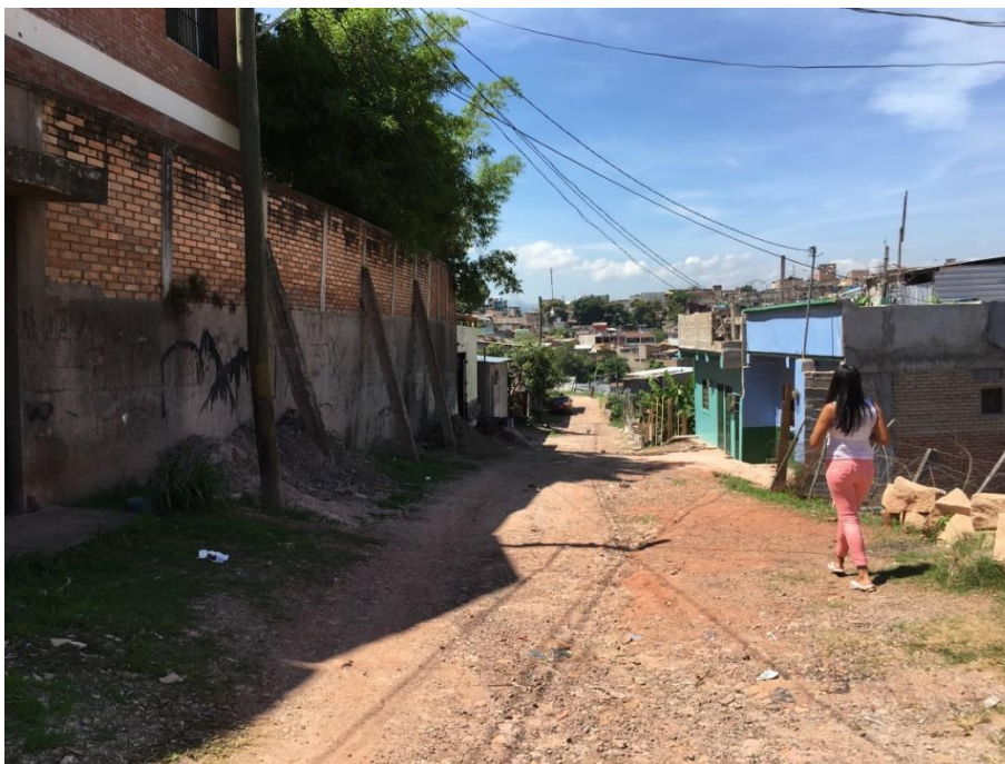
2. VISTA TRAMO INTERMEDIO DE CALLE A PAVIMENTAR
