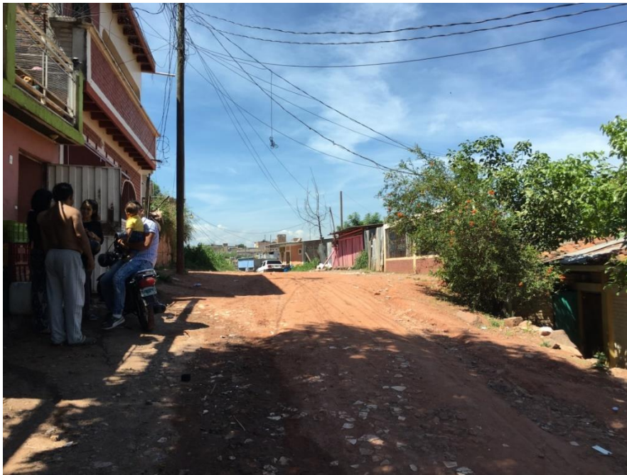
1. VISTA DE ESTADO ACTUAL DE CALLE A PAVIMENTAR
