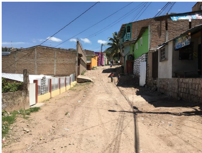
4. VISTA PANORAMICA DE CALLE A PAVIMENTAR
