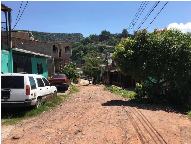
3. VISTA PANORAMICA DE CALLE A PAVIMENTAR
