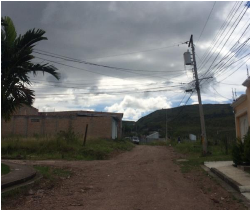
Vista de calle a reparar
