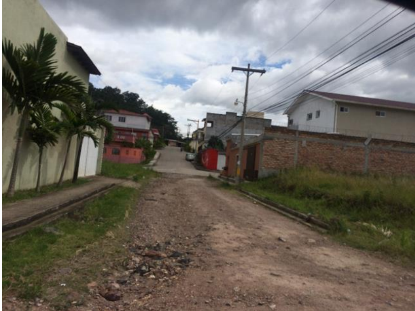
Inicio de calle a pavimentar tramo 2
