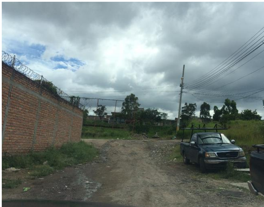
Final de calle a pavimentar tramo 1
