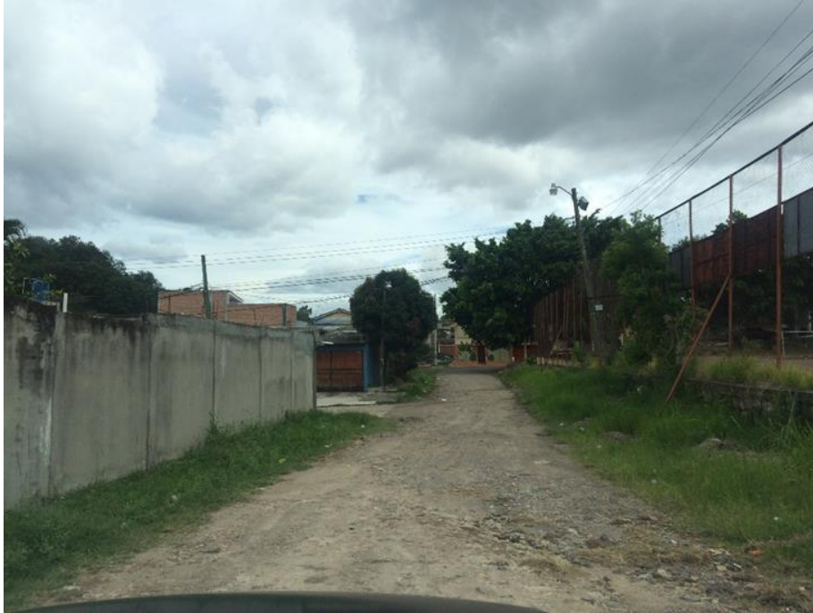
Vista de calle a pavimentar con concreto hidráulico tramo 1
