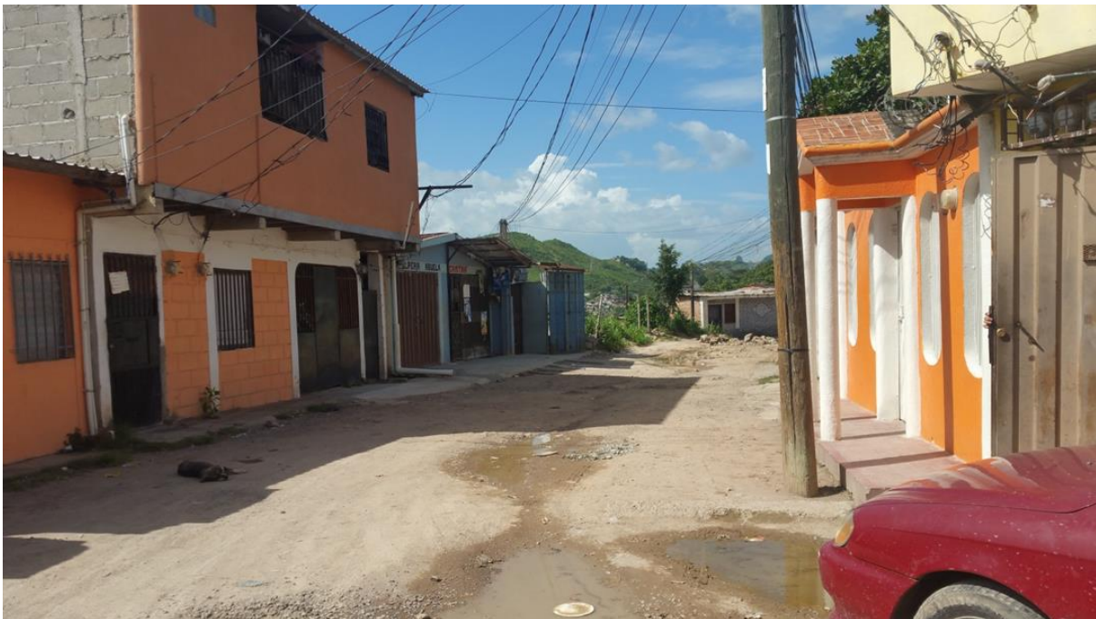
VISTA DE LA CALLE A PAVIMENTAR
