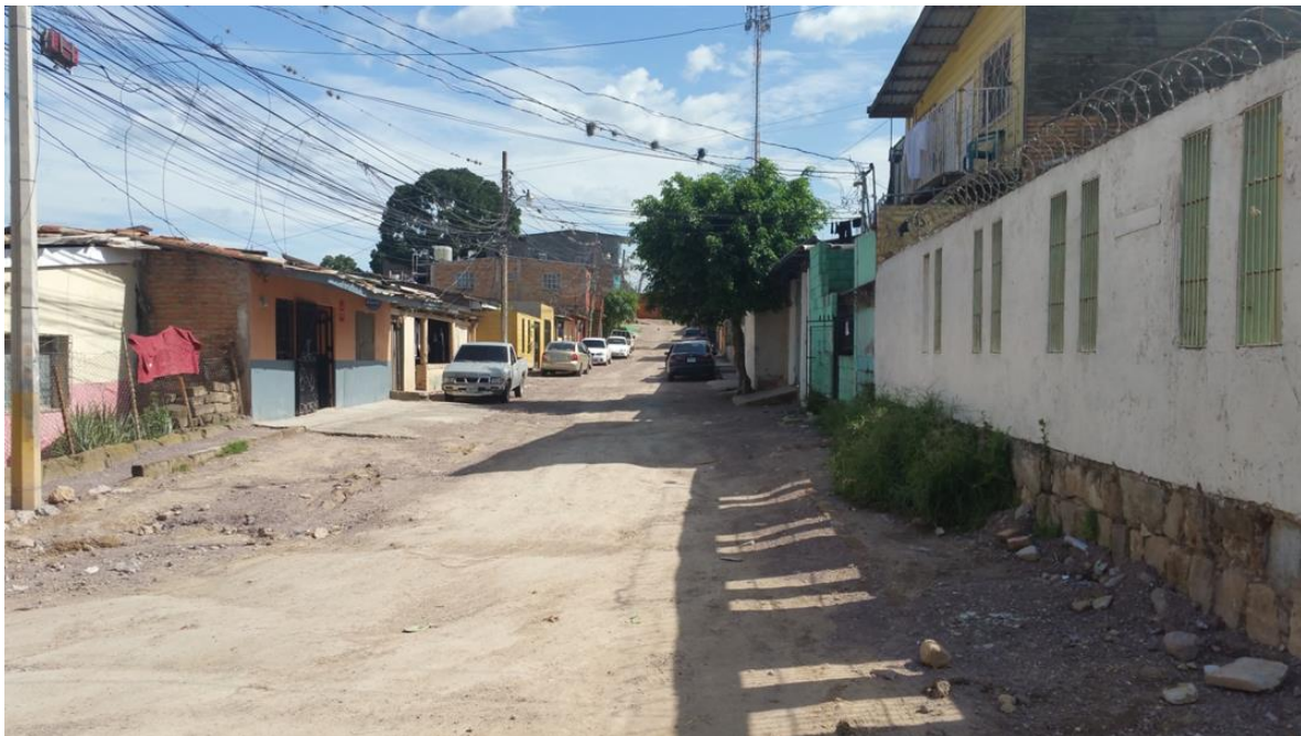
VISTA DE LA CALLE EN MAL ESTADO
