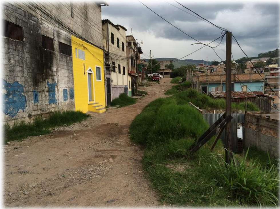
VISTA DE DONDE SE CONTRUIRA EL MURO 2
