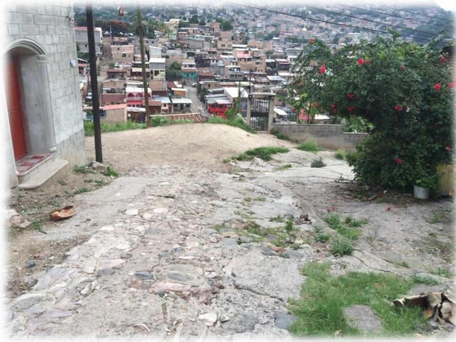
VISTA DEL ESTADO DE CALLE EXISTENTE
