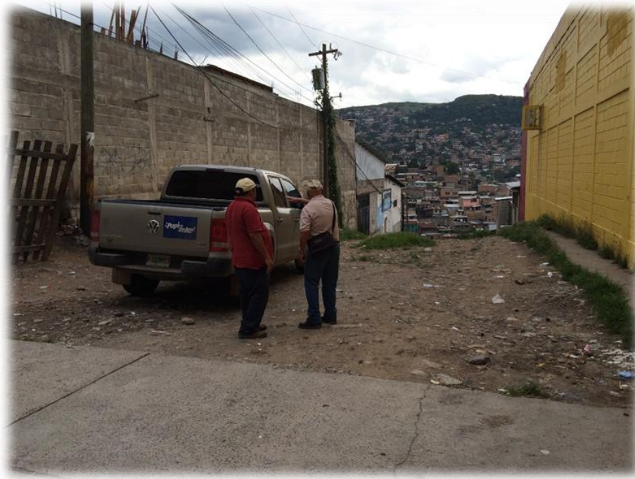
INICIO DE PAVIMENTACIÓN CON CONCRETO HIDRÁULICO
