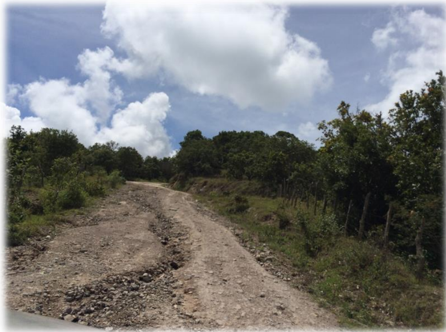
FINAL DE CALLE EN LA QUE SE HARÁ EL BALASTADO
