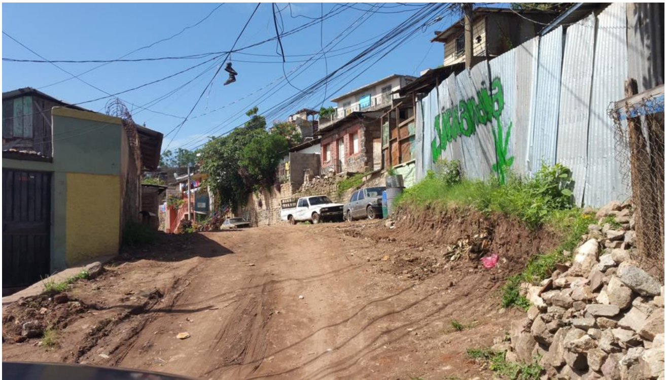
VISTA DE LA CALLE EN MAL ESTADO
