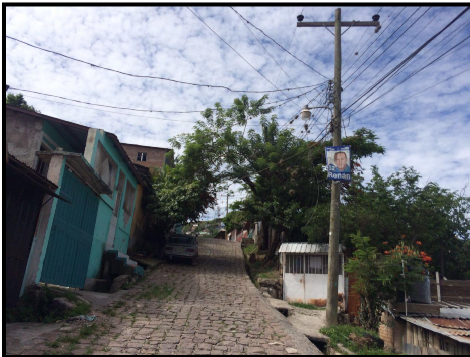
Foto No. 2: Vista donde se hará el white topping
