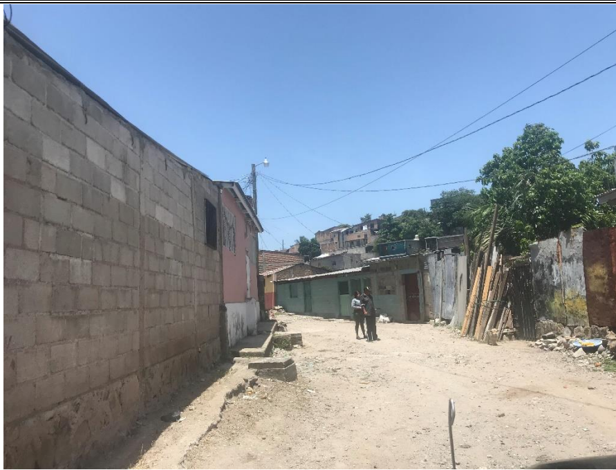
No.2 SE PUEDE OBSERVAR EL ESTADO DE LA CALLE Y LA NECESIDAD DE PAVIMENTAR
