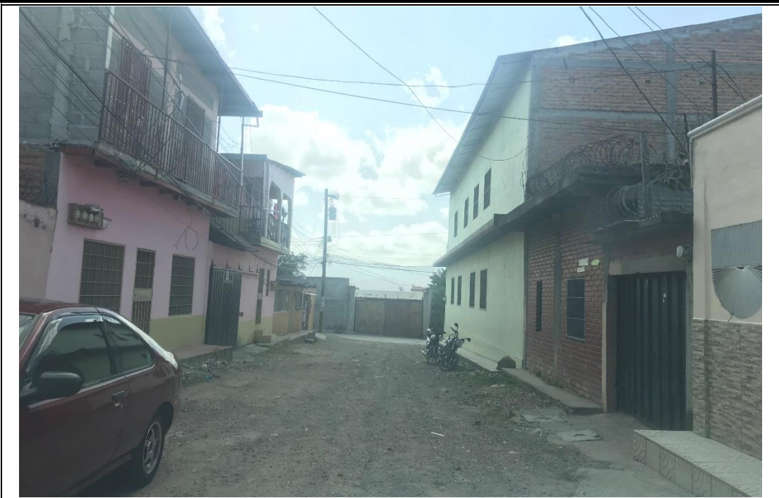
No. 6 VISTA DE LA CALLE A PAVIMENTAR CON CONCRETO HIDRAULICO
