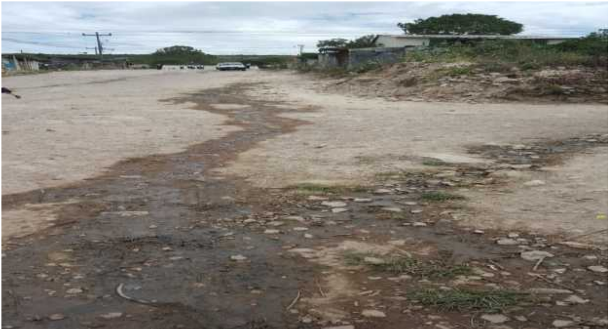
Construcción de cunetas en col. Reynel Funez
