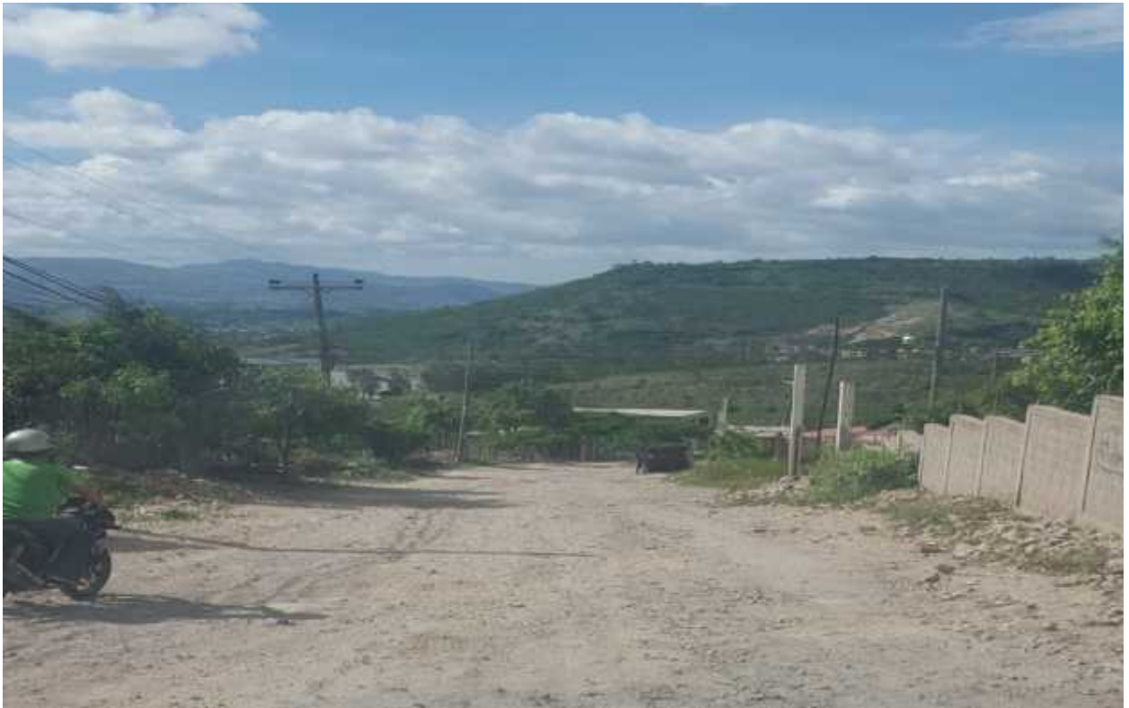
Tramo de calle a reparar
