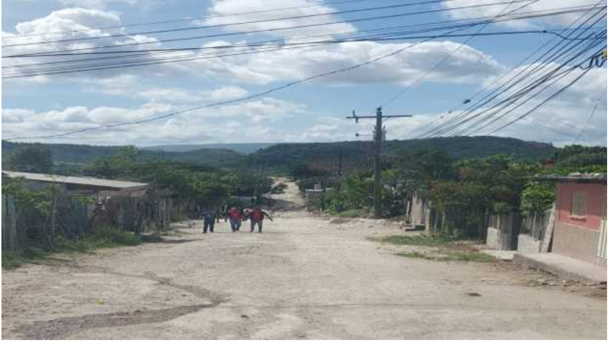
Reparación de calle col. Reynel Funez
