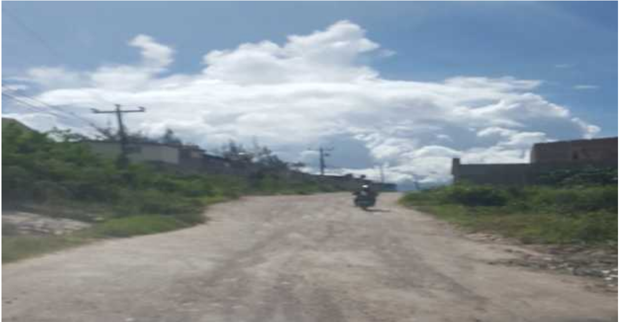
Inicio de proyecto de conformación y balastado
