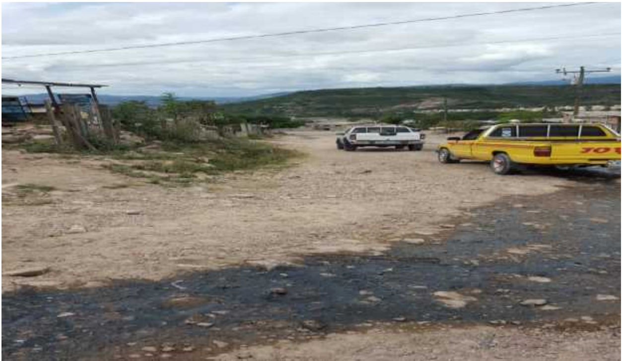
Tramo donde se construirán las cunetas
