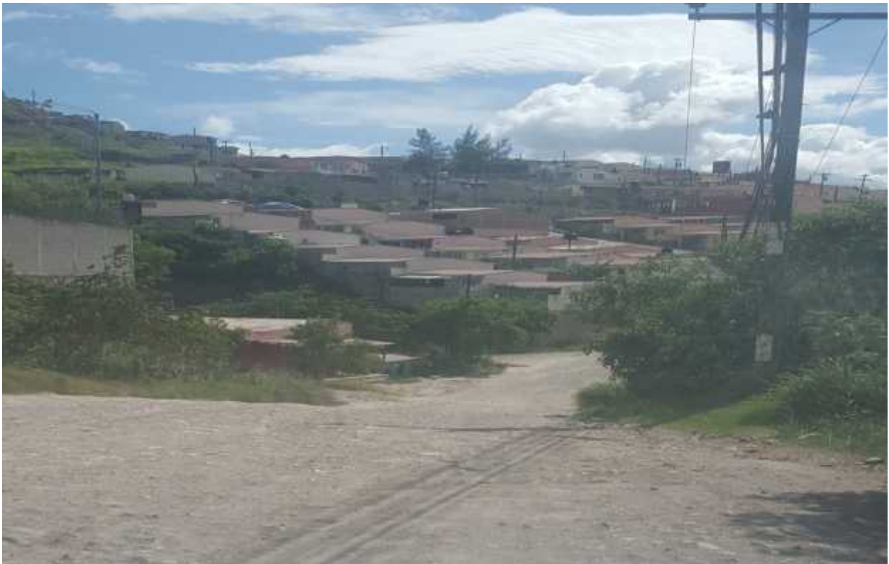
Vista panorámica de calle a reparar
