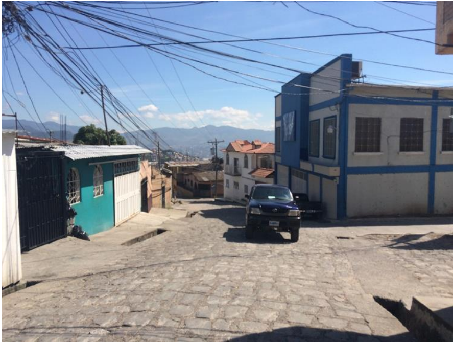
Calle a pavimentar
