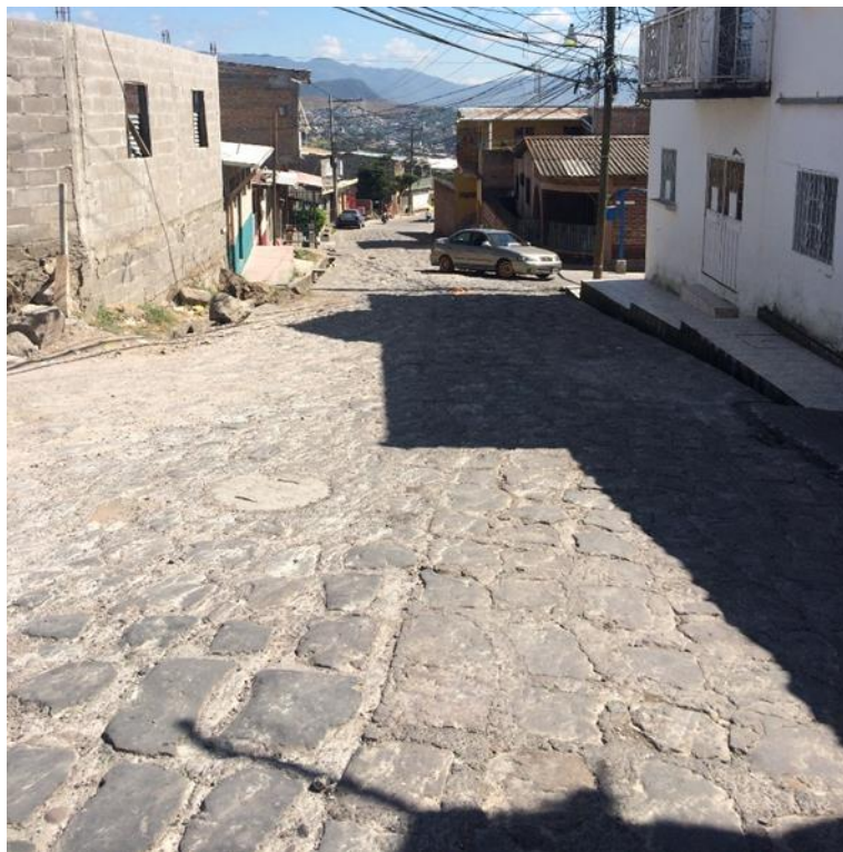
Vista de la calle cuyo tratamiento sera white topping
