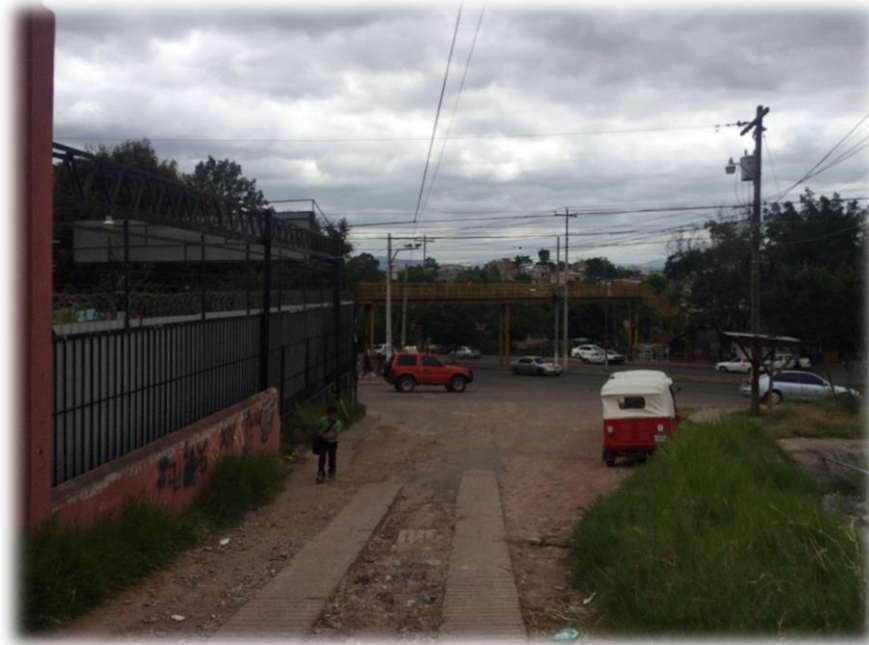
INICIO DE PAVIMENTACIÓN CON CONCRETO HIDRÁULICO
