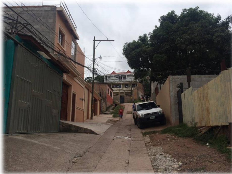
PLANCHAS DE CONCRETO Y HUELLAS VEHICULARES A DEMOLER
