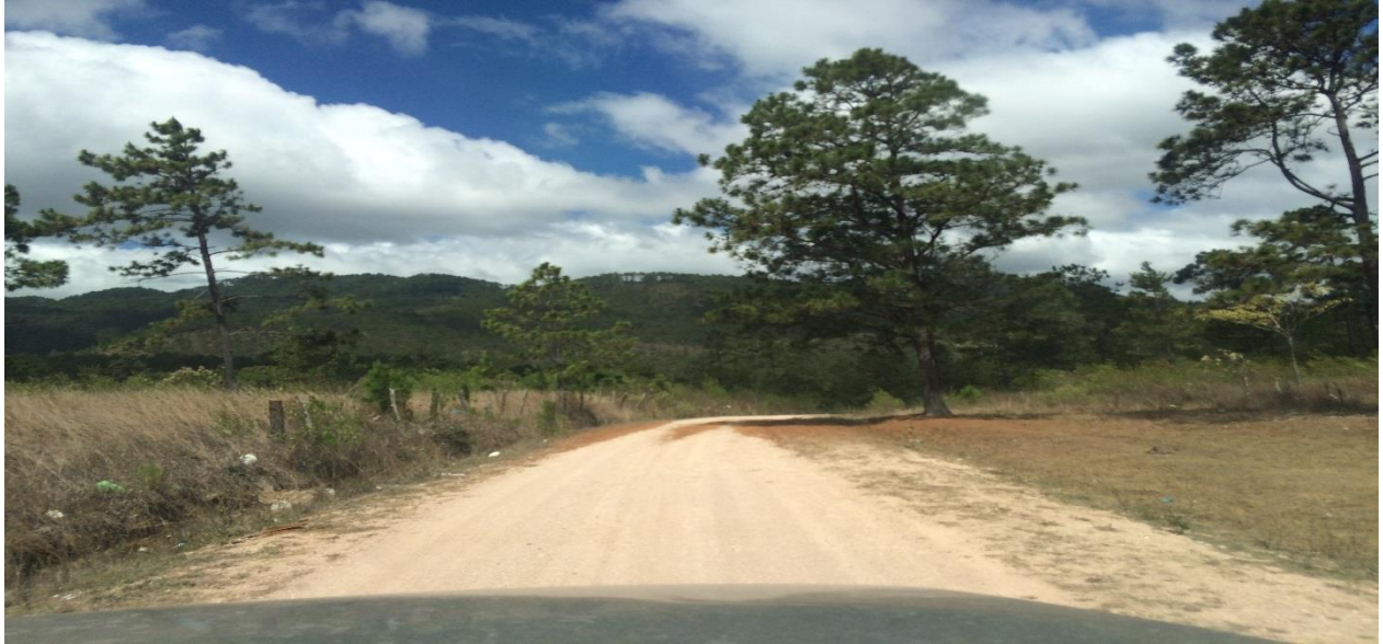
VISTA DE CALLE A REPARAR
