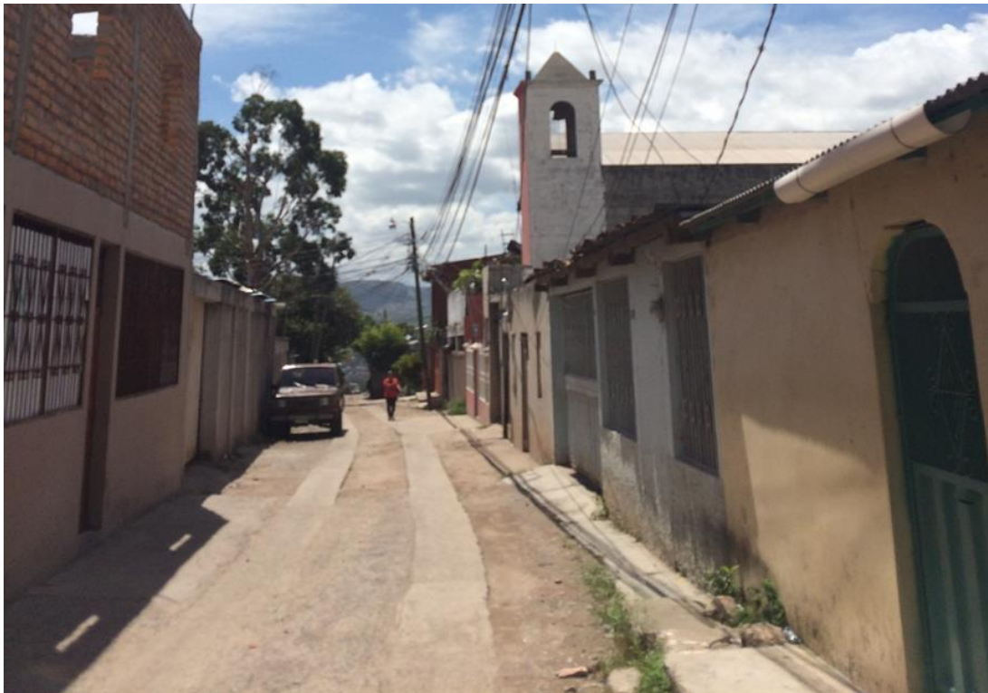
VISTA DE LA CALLE EN MAL ESTADO
