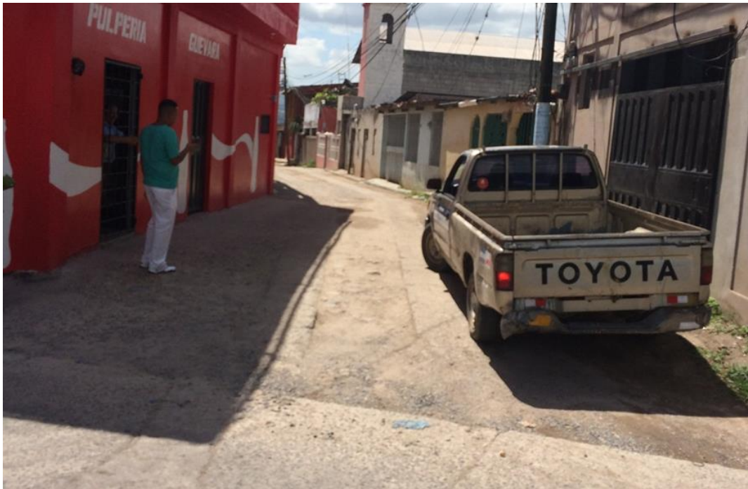
INICIO DE LA CALLE A PAVIMENTAR
