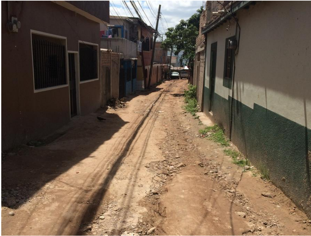
VISTA PANORAMICA DE LA CALLE
