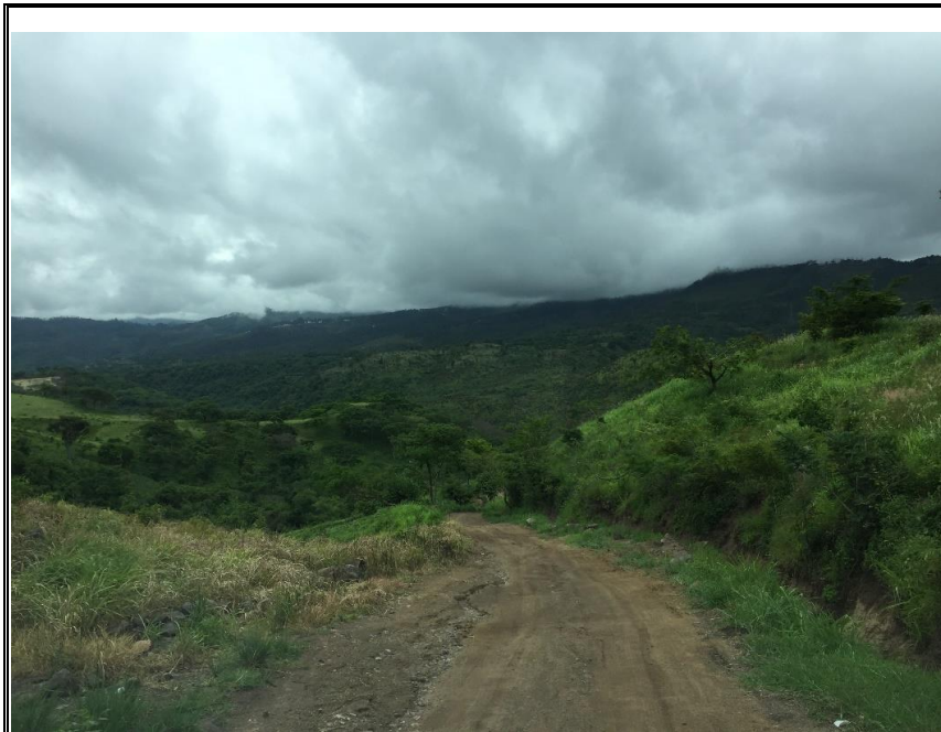
N° 2 Se observan las malas condiciones de la calle esto debido a escorrentía superficial en la época lluviosa
