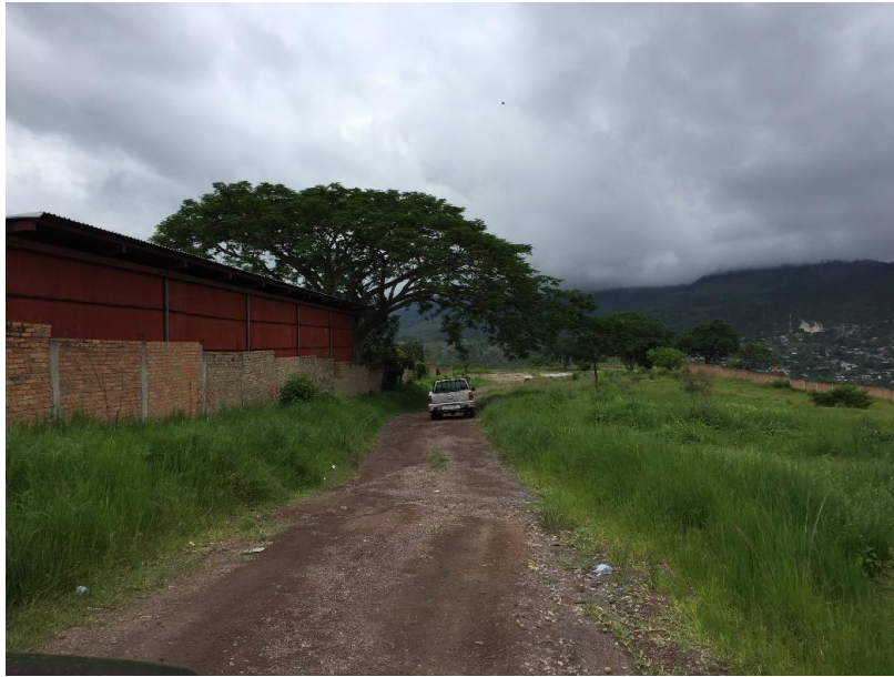
N° 1 Se observan las malas condiciones de un tramo de la calle a conformar y balastar
