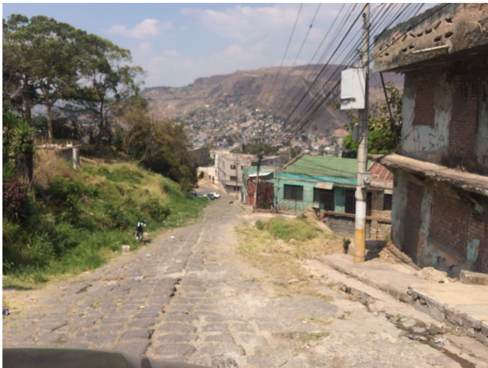
FINAL DE CALLE A PAVIMENTAR
