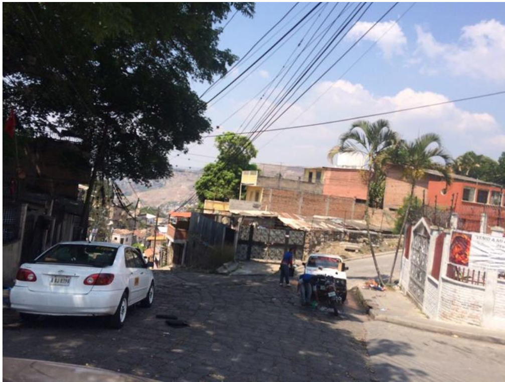
INICIO DE CALLE A PAVIMENTAR CON CONCRETO HIDRAULICO
