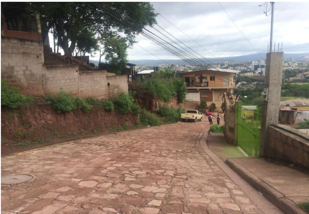
FINAL DE CALLE A PAVIMENTAR CON WHITE TOPPING
