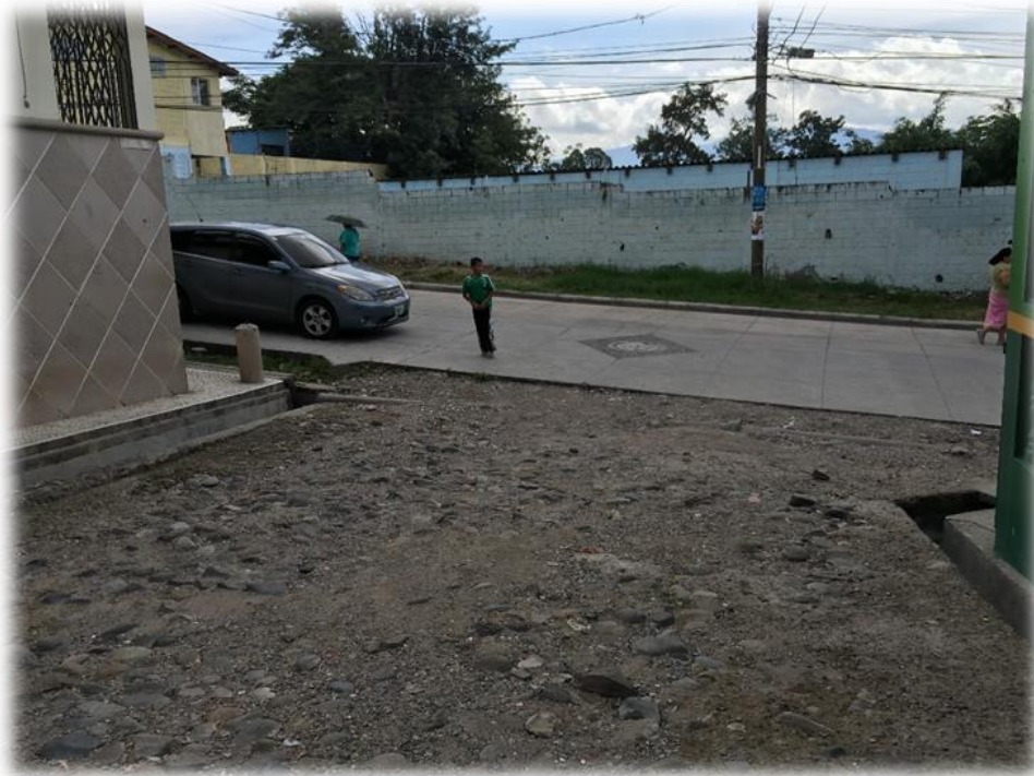
VISTA DE DONDE SE CONSTRUIRA EL DRAHAJE TIPO QUIEBRAPATA
