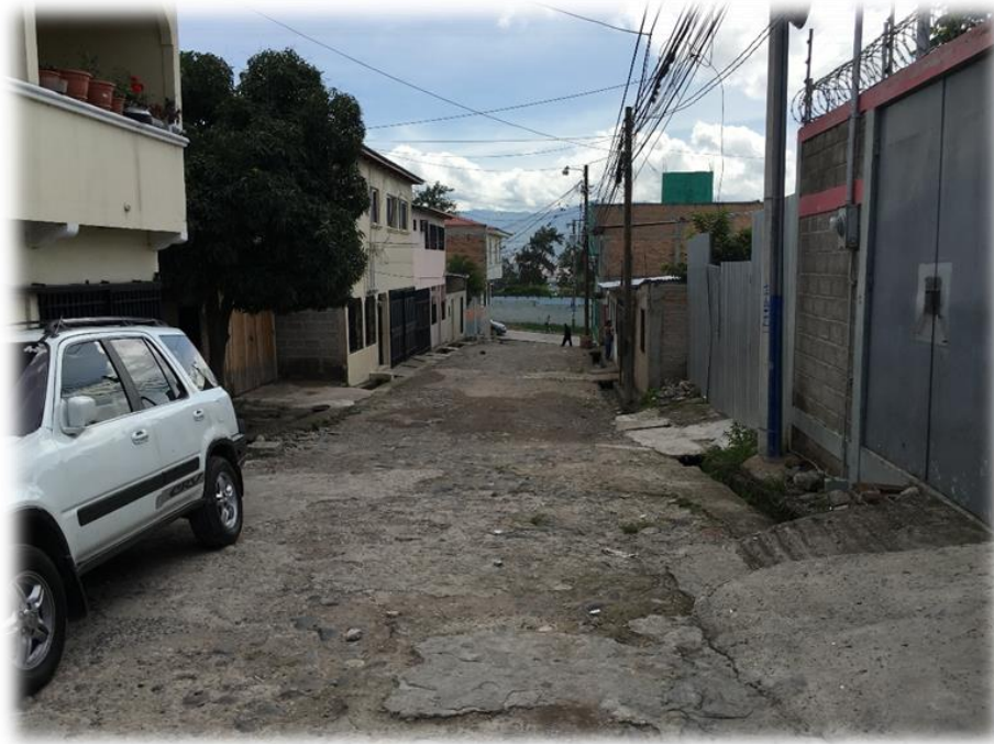
INICIO DE PAVIMENTACIÓN CON CONCRETO HIDRÁULICO.
