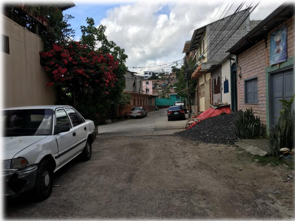
FINAL DE CALLE A PAVIMENTAR
